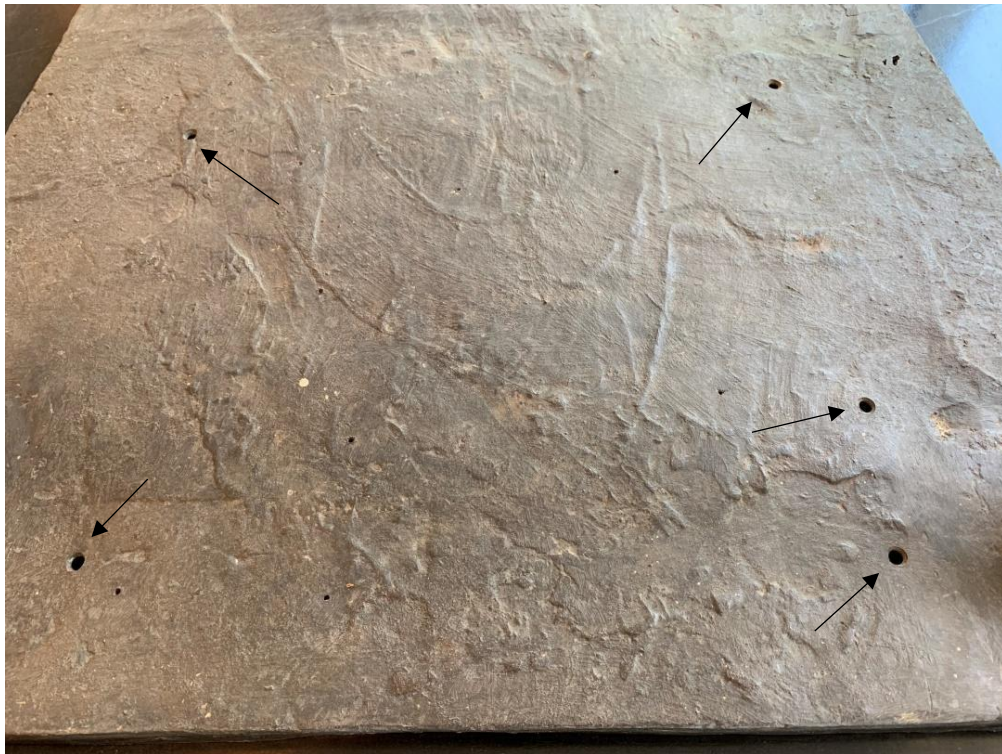
Figura 31 - Furos redondos na base, indicados pelas setas (Foto fornecida por Ariane Lavezzo).
