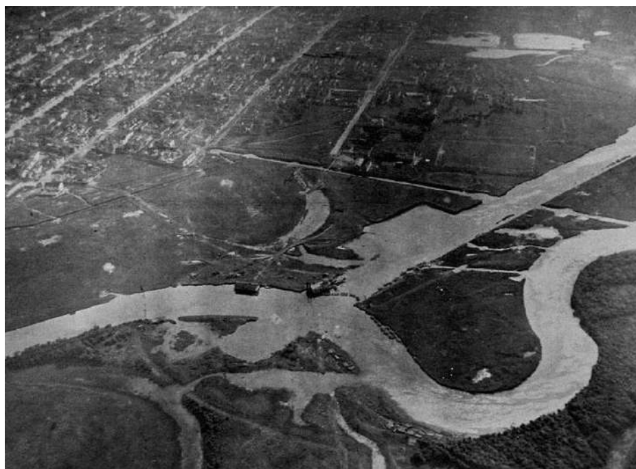
Figura 51: Obras de retificação do rio Tietê - anos 40
