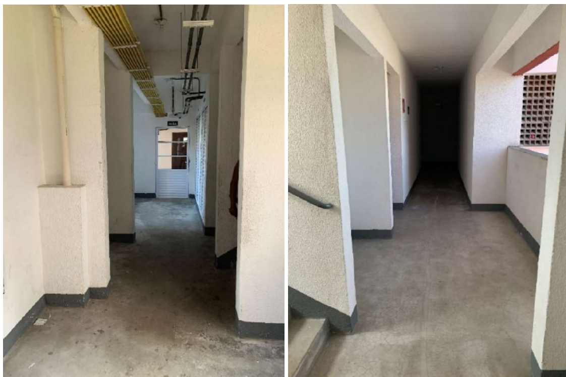
Figura 14: Circulação no térreo à esq. e no pavimento tipo à dir. - Fonte: o autor (2022)
