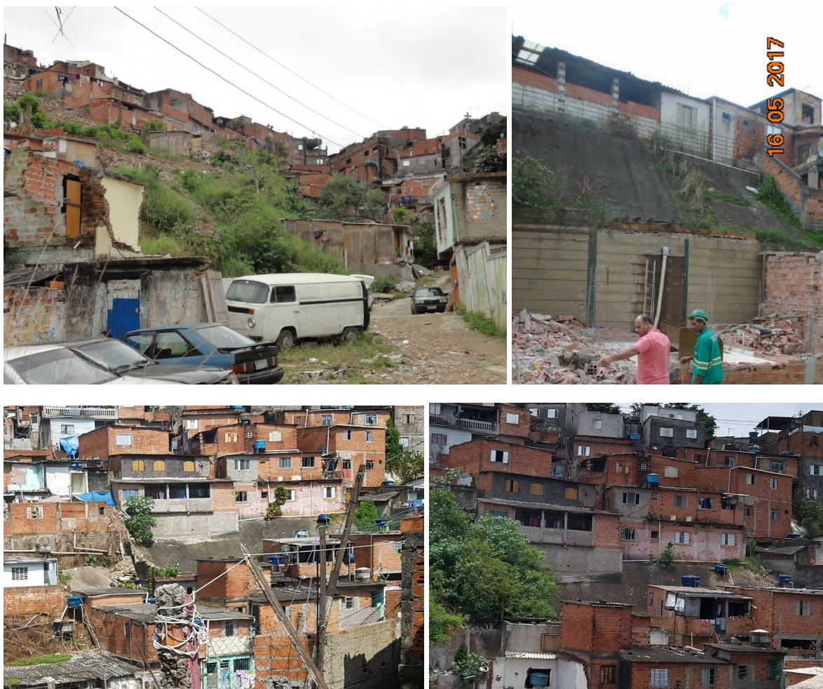
Figura 10. Talude de corte próximo à Viela Gabiroba nos anos de 2015 (esq. sup.) e 2017 (dir.sup), 2019 (esq. inf.) e 2021 (dir. inf.). Notar a presença do concreto projetado a partir da imagem do ano de 2017.
