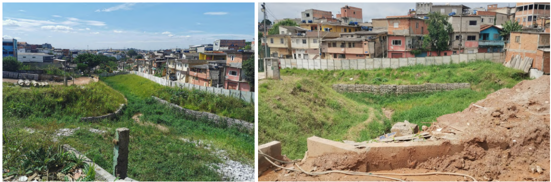
Figura 19. Região de baixada com muros de gravidade e de gabião instalados, em 2021 (esq.) e 2024 (dir.). Fonte: COMDEC (2021, esq.) e autoria própria (2024, dir.)
