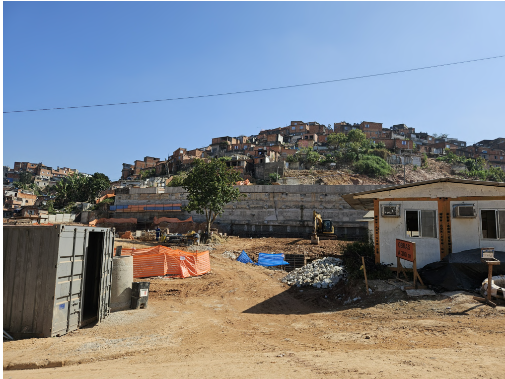
Figura 30. Cortina atirantada construída sobre a encosta oeste da meia-vertente.
