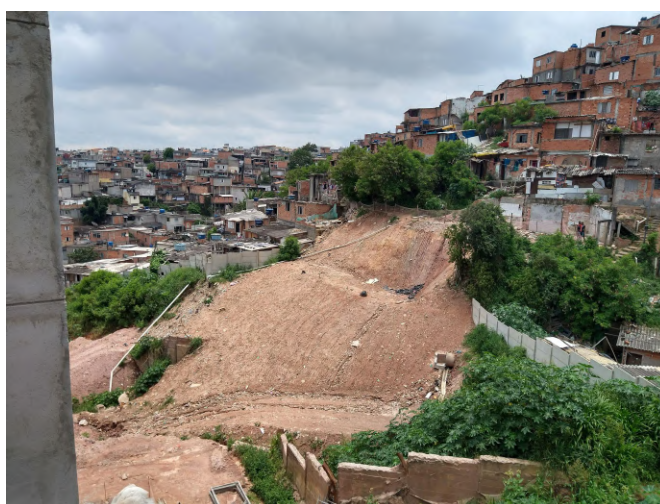
Figura 29. Terraplanagem e condução/retificação do córrego transversal. Fonte: COMDEC, 2021.
