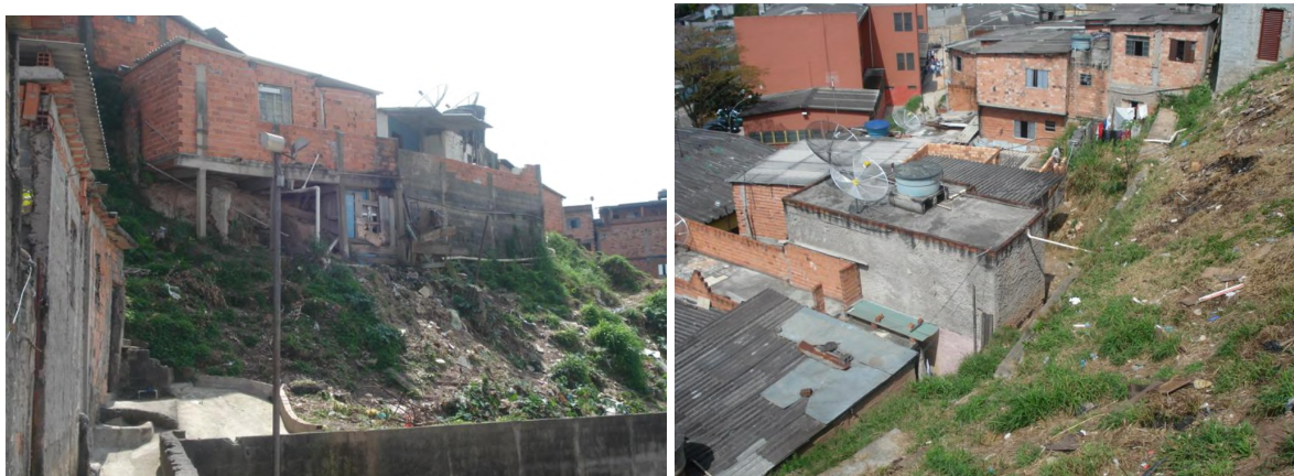
Figura 22. Moradias no topo e na base do talude de corte. Fonte: IPT, 2010.
