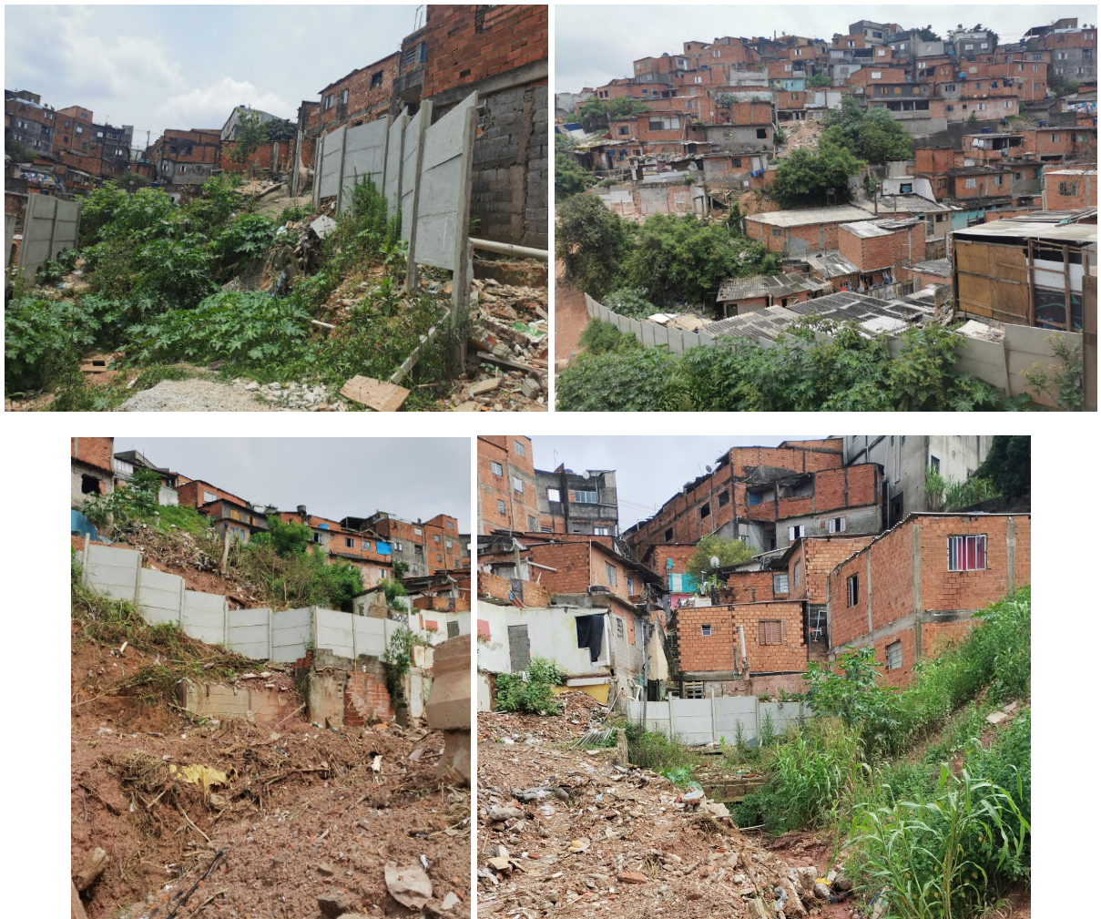
Figura 12. Muros de concreto contornando as casas das partes mais altas do morro do Alto da Alegria, nos anos de 2021 (sup. Fonte: COMDEC) e 2024 (inf.).
