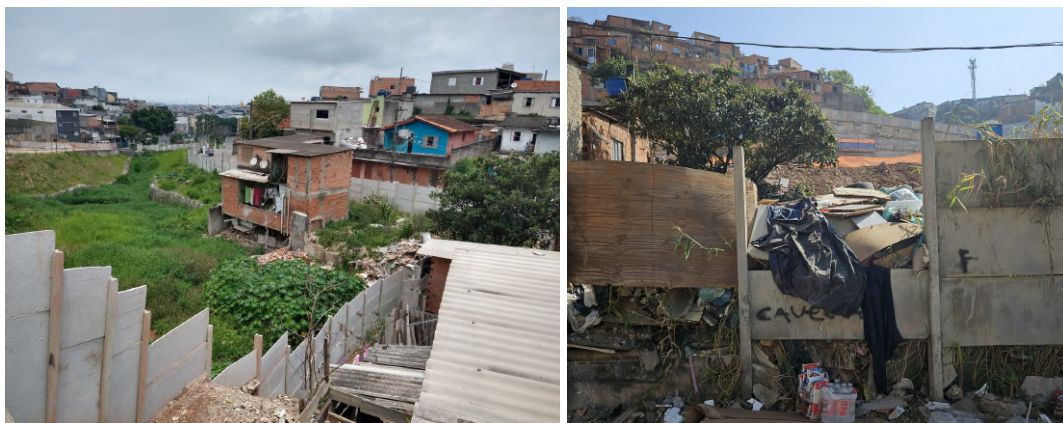
Figura 16. Região de início do córrego. Notar moradia isolada no interior da área contornada pelo muro (esq.). Área de descarte de lixo e entulho (dir.). Fonte: COMDEC, 2021 (esq.). Autoria própria, 2024 (dir.).
