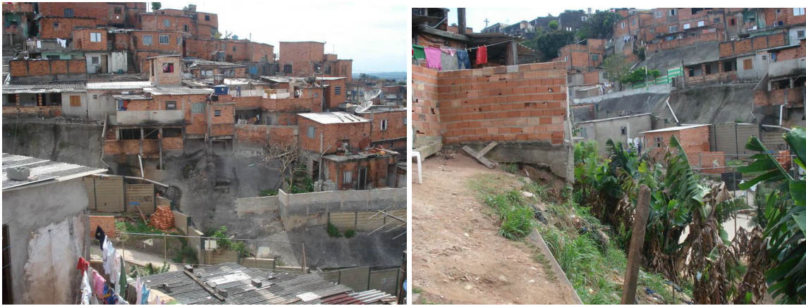
Figura 26. Concreto projetado lançado sobre as encostas da região central do Alto da Alegria. Fonte: IPT, 2010.
