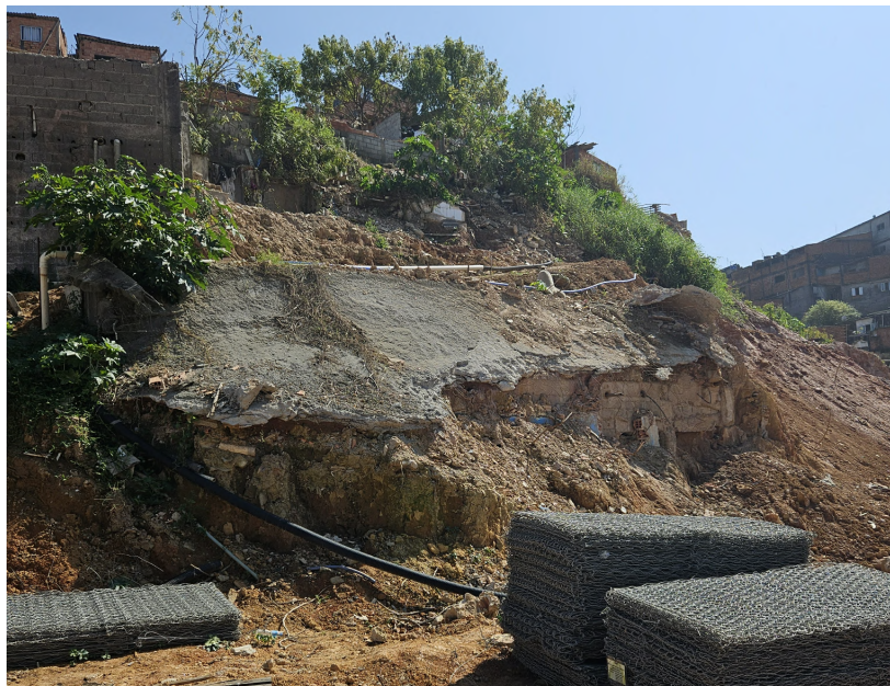
Figura 32. Concreto utilizado para conter a movimentação no talude superior.
