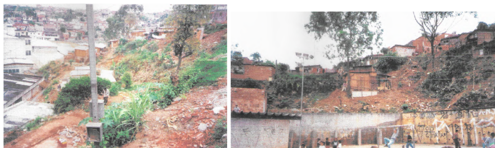
Figura 20. Invasões abaixo da Viela União. Notar muito da divisa com umidade causada pelo lançamento de esgoto dos barrancos (dir.). Fonte: PMSP, 1996.
