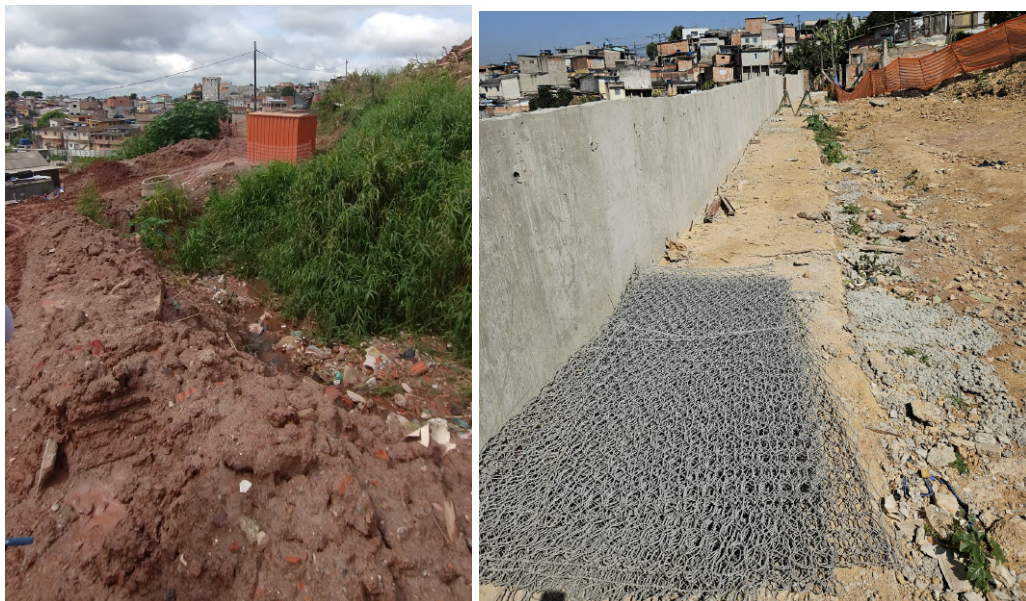
Figura 31. Área anterior ao talude onde foi construída a cortina atirantada. Em fevereiro de 2024 (esq.) havia um excesso de material de aterro misturado ao solo residual, além de uma vegetação arbustiva, enquanto em agosto (dir.), a berma do talude foi planificada. Notar a imagem à direita que está de frente para o selo da cortina.
