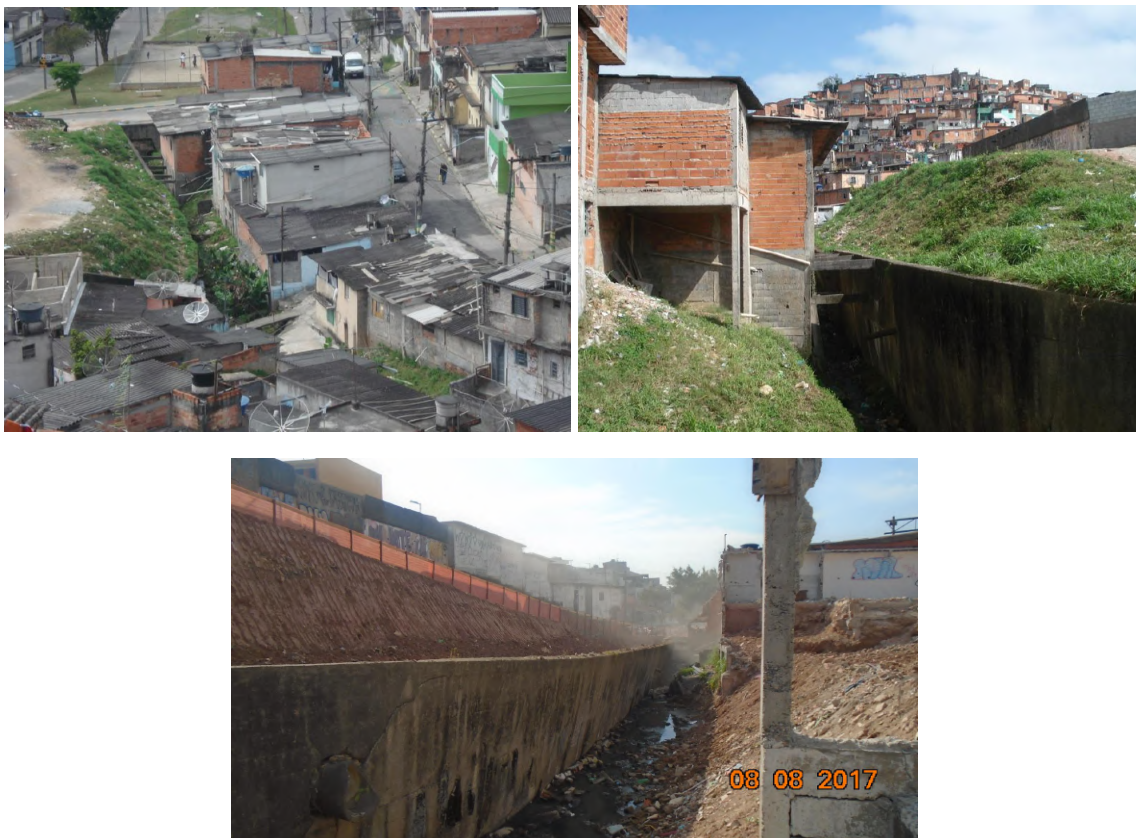
Figura 18. Construções a margem do córrego, vista geral (esq. sup.). Muro de contenção do aterro (dir. sup.). Fonte: IPT, 2010. Muro de contenção para o aterro da escola (inf.). Notar que é o mesmo muro da Figura 13 (dir.). Fonte: COMDEC, 2017.
