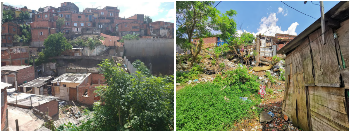
Figura 28. Concreto projetado e muro de contenção implementados nas encostas da região de meia vertente (esq.). Encosta com barracos de madeira, construções de alvenaria e lixo descartado (dir.). A presença de roupas nos varais de certas casas vizinhas indicam que algumas ainda estavam ocupadas, enquanto outras já haviam sido (em parte) destruídas. Fonte: COMDEC, 2021.
