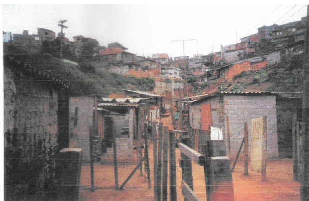
Figura 13. Construções de alvenaria e madeira ao longo do talvegue longitudinal. Fotografia tirada no final da Rua Ezequiel Lopes Cardoso. Fonte: Tecnosolo, 1996.
