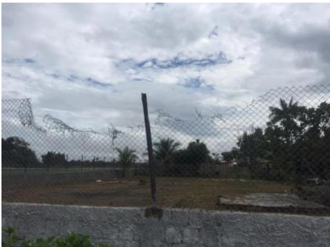
Figura 28 - Vista da cerca metálica e dos danos causados pela colisão. Fonte: http://sistema.cenipa.aer.mil.br/cenipa/paginas/relatorios/rf/pt/PRBRU_01FEV2019_IG..pdf
