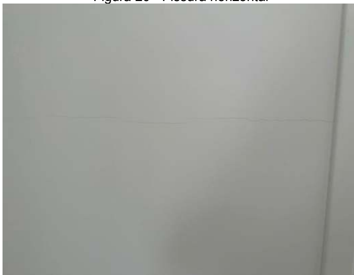
Figura 20 - Fissura horizontal
