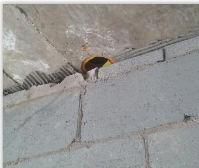
Figura 18 – Caixa de passagem em distribuição na alvenaria
