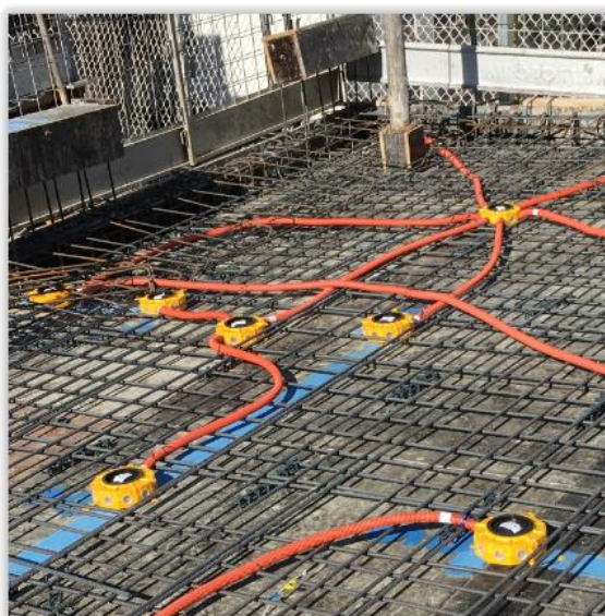
Figura 16 – Kit elétrico distribuído na laje
