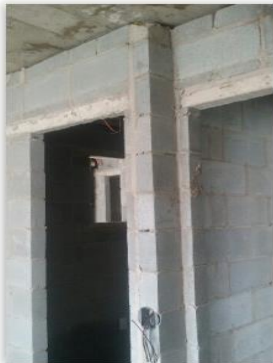
Figura 19 – Caixas para interruptor e tomada posicionadas
