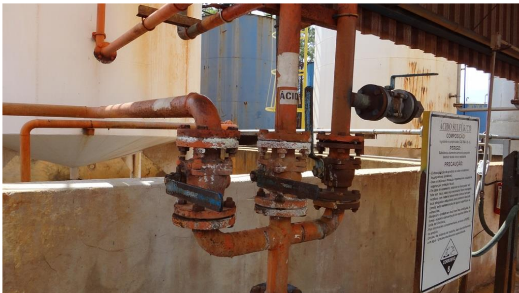
Figura 12 - Índices de vazamento em juntas da tubulação de ácido sulfúrico.
