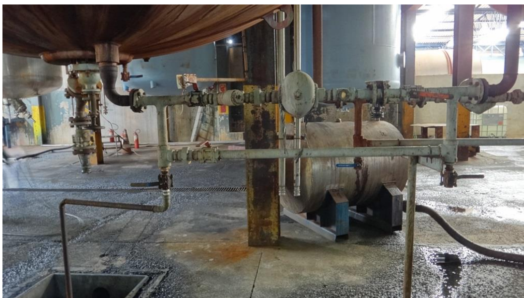
Figura 11 - Tanque de transferência usado para carregamento de Naftaleno.
