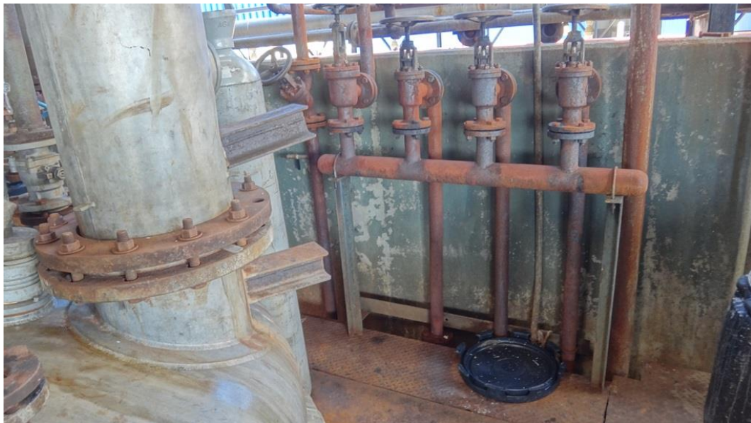
Figura 17 - Tubulações e distribuidor de vapor sem isolamento e acessíveis.
