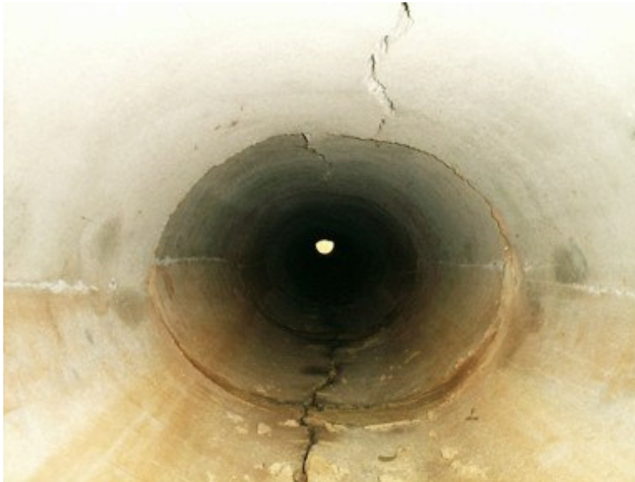
Figura 3 - Tubulação de esgoto danificada.
