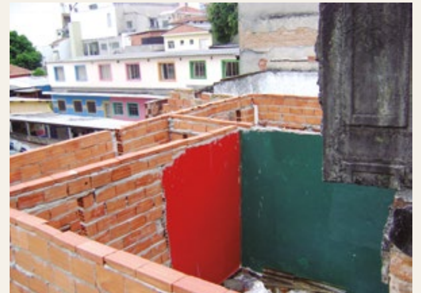
Segundo andar de casa em construção nos fundos
