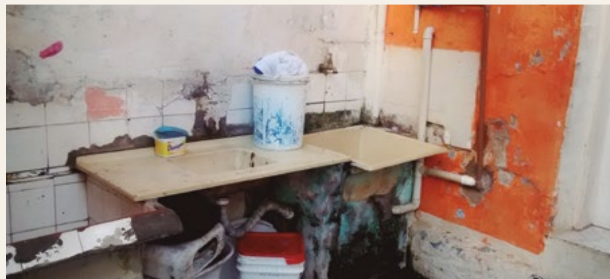
No térreo, tanques
