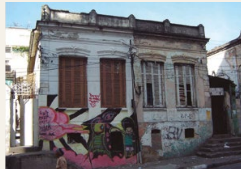
Fachada Casas 21 e 31, 2007. Fonte: Ibid.
