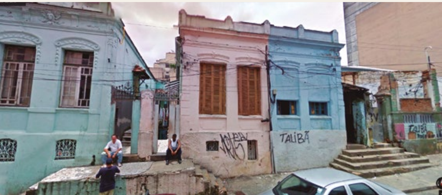
Conjunto 19 a 33 (2010). Fonte: Google Street View
