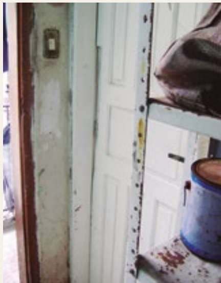
Porta de banheiro individual nos fundos
