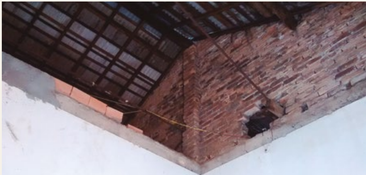
Quarto sem forro, onde se vê a estrutura em alvenaria de tijolos e a estrutura do telhado
