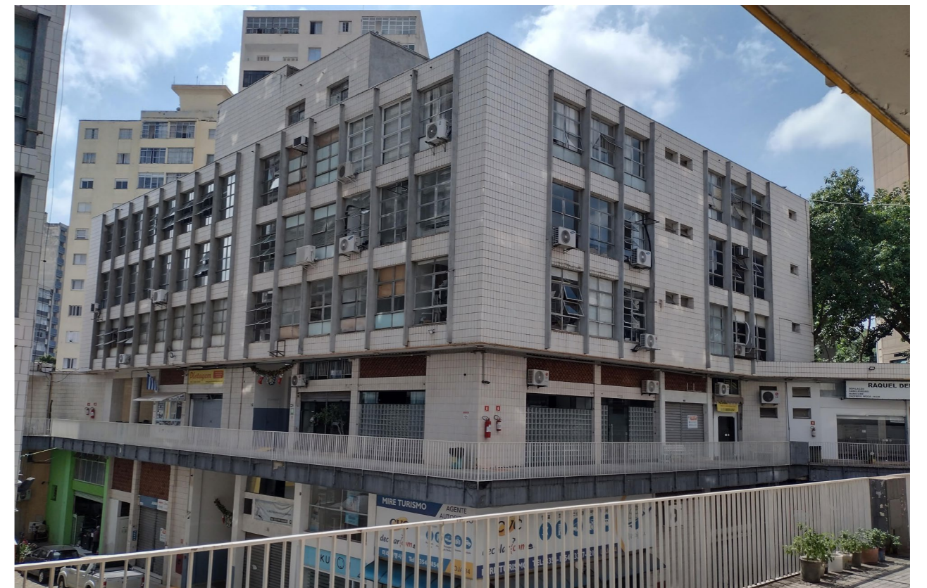
(1) Vista do bloco B a partir do bloco C (rua elevada) (2) Vista do bloco C a partir do bloco B (rua elevada) Fonte: Autoria própria, out. 2020
