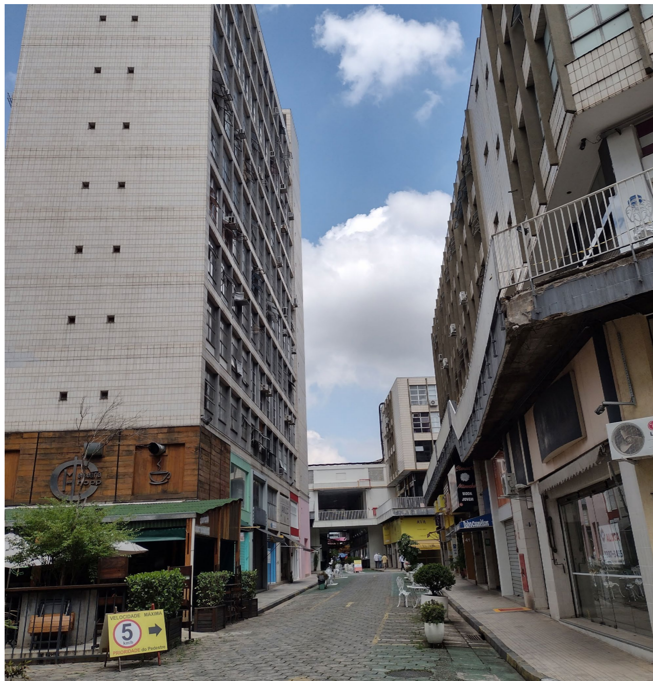
Vista interna. Acesso à rua José Paulino no centro, ao fundo. À esquerda, o bloco D. À direita, transição entre blocos A e F. Fonte: Autoria própria, out. 2020
