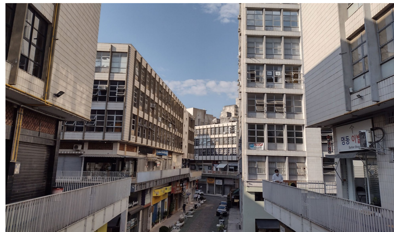
Acesso à rua José Paulino pela rua elevada. No primeiro plano, bloco B à direita e bloco A à esquerda. No segundo plano, bloco D à direita e bloco A à esquerda. Ao fundo, bloco E. Fonte: Autoria própria, jul. 2021
