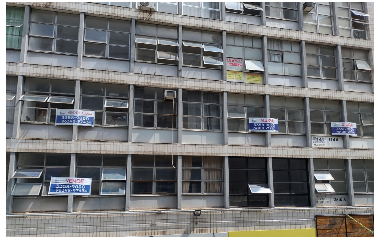
(1) Bloco de circulação vertical do 2º pavimento do bloco D e corredor de acesso às unidades.
