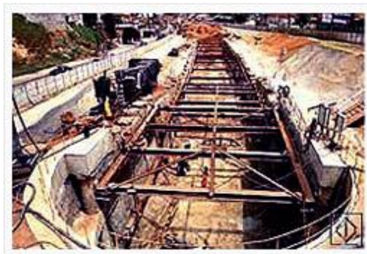
Figura 24 - Método Vala a céu aberto (VCA) (METRÔ, 2012).
