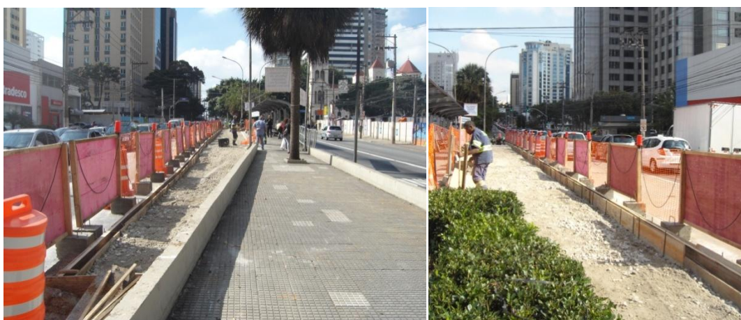
Figura 43 - Obras de desvio de tráfego na av. Ibirapuera
