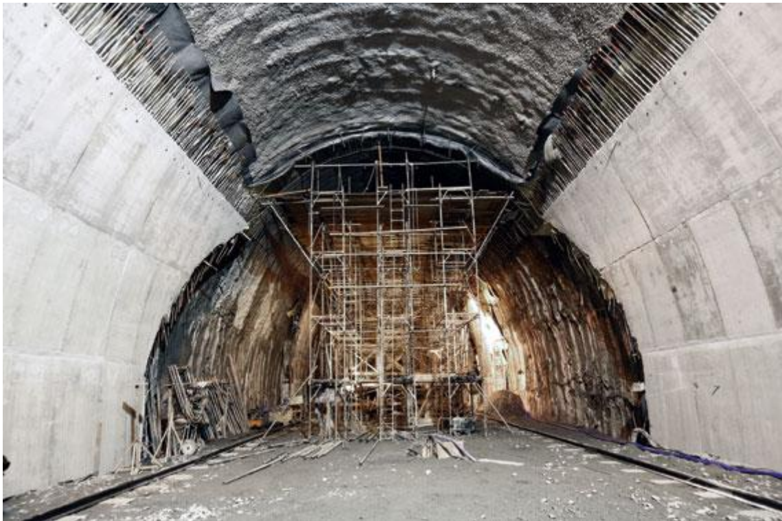
Figura 27 - NATM utilizado para execução do túnel Higienópolis (MEDEIROS, 2011).
