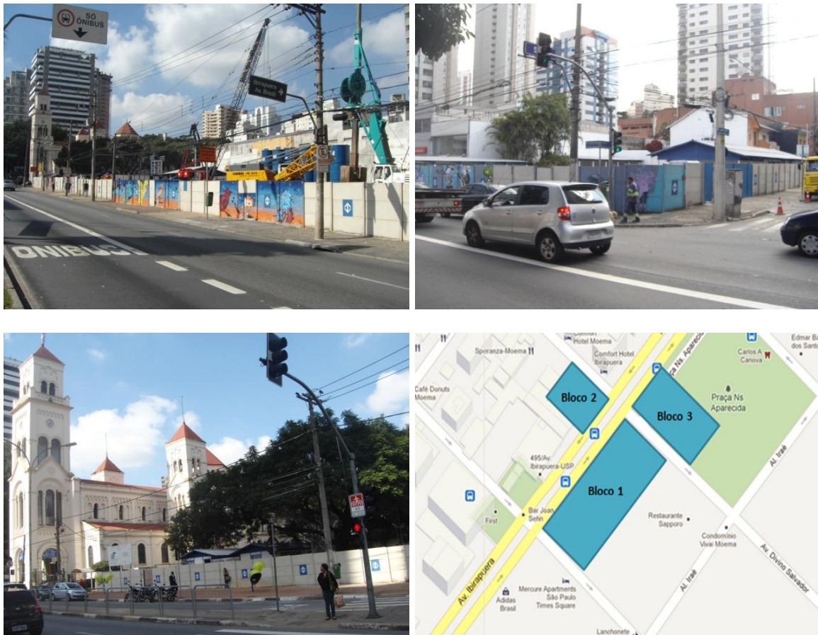
Figura 44 - Indicações dos blocos 1, 2 e 3 do canteiro de obras.
