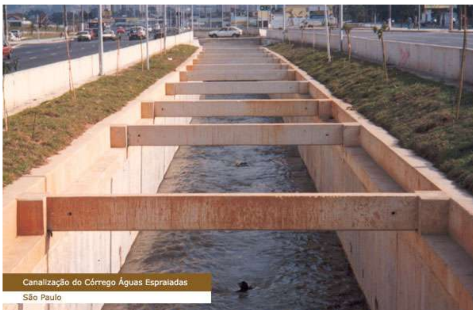
Imagem 4: Córrego Água Espraiada canalizado. Foto: Fundesp
