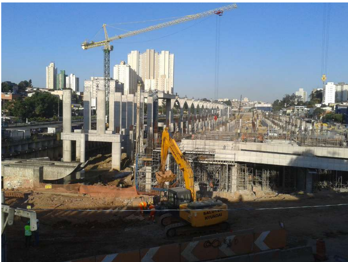
Imagem 31: Vista do futuro pátio Água Espraiada, pertencente ao Metrô. Esta área será utilizada para a manobra e manutenção dos trens da linha 17 – Ouro e se localiza nas proximidades do cruzamento entre a avenida homônima e a Washington Luís. Nota-se que mesmo com mais de dois anos de andamento, as obras se encontram ainda na etapa de fundações. Foto: Marcelo Saccomann. Agosto de 2015.
