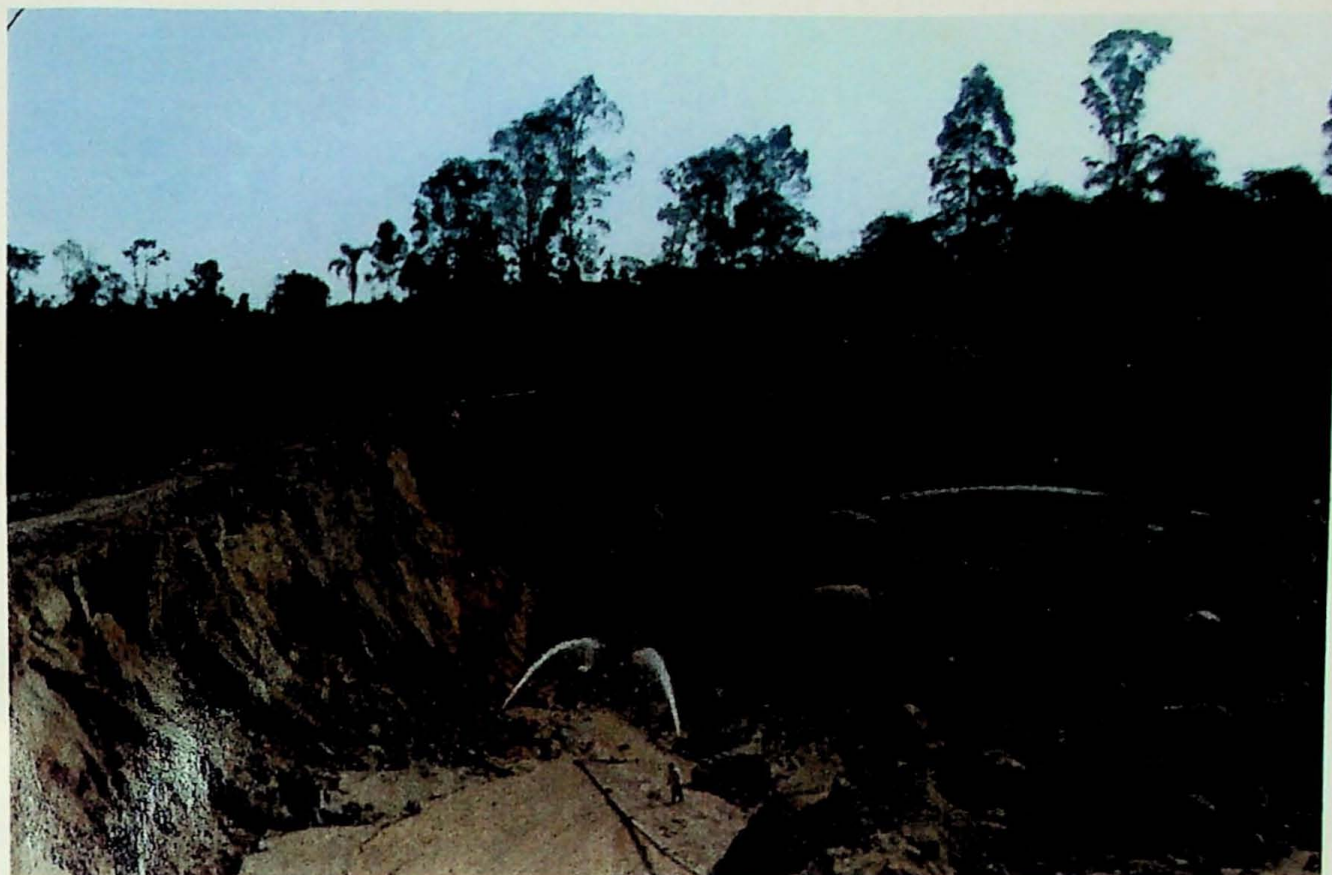
Foto 03 - Vista da cava seca onde foram coletada as amostras de areia proveniente do maciço alterado, observa-se o desmonte hidráulico através de jatos de água.
