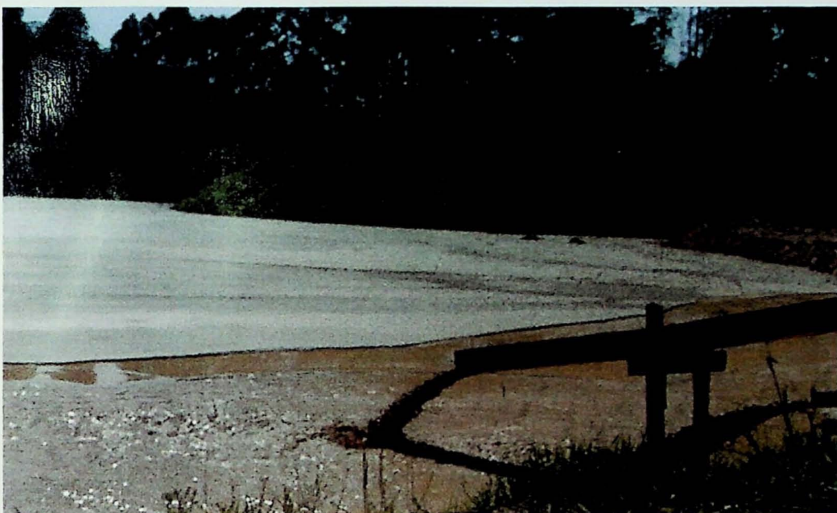
Foto 04 - Bacia de decantação onde se deságua o material overflow
