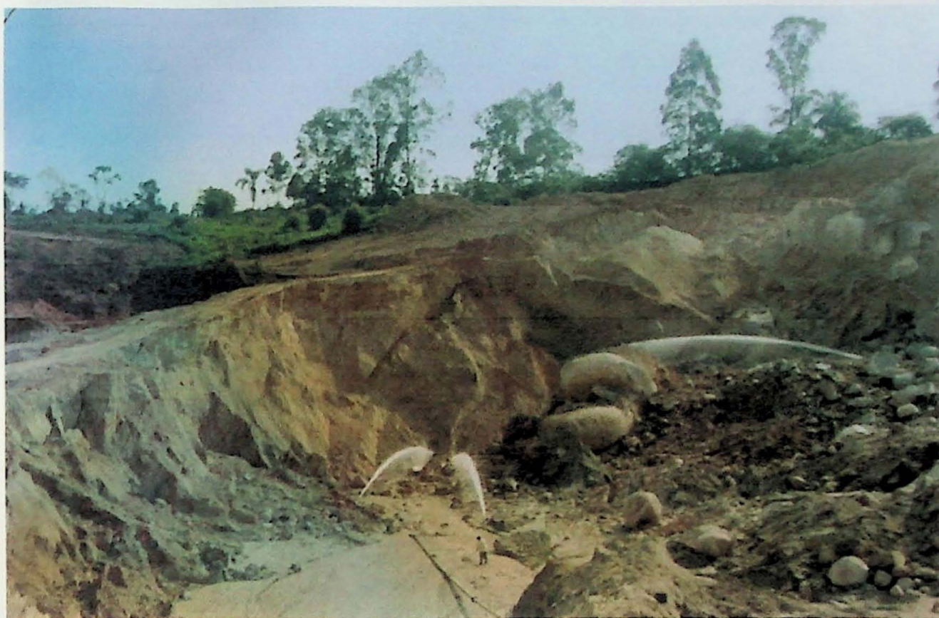
Foto 03 - Vista da cava seca onde foram coletadas as amostras de areia proveniente do maciço alterado, observa-se o desmonte hidráulico através de jatos de água.
