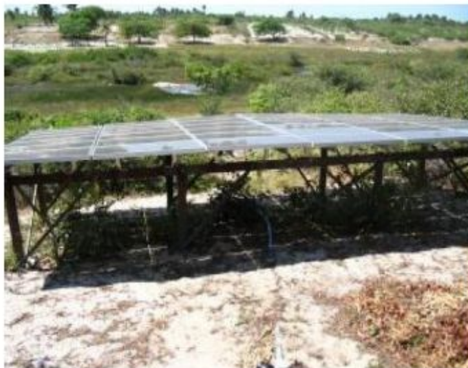
Figura 35 - Sistema fotovoltaico para bombeamento de água na Comunidade de Bom Jesus
