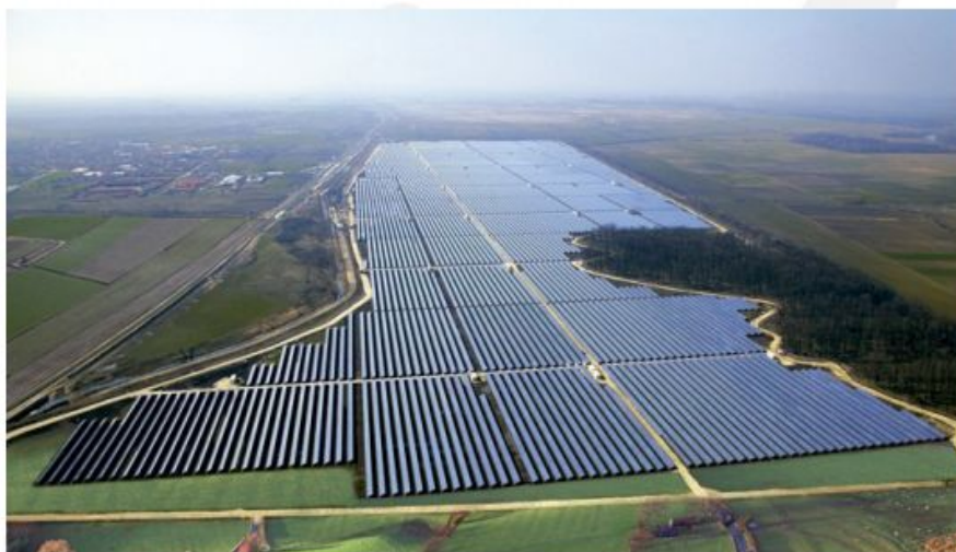
Figura 27 - Usina fotovoltaica de 225 MWp em Ituverava na Bahia
