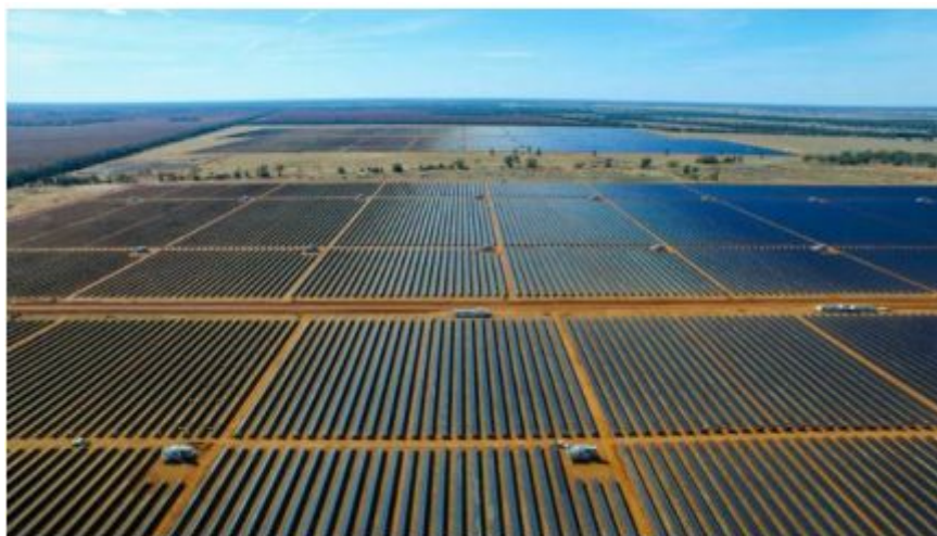
Figura 26 - Usina fotovoltaica (UFV) de 150 MWp em Bom Jesus da Lapa na Bahia
