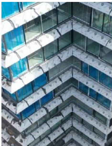
Figura 35- Instalação do fechamento de ACM
