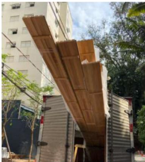
Figura 37- Forro de madeira em placas moduladas para otimizar instalação
