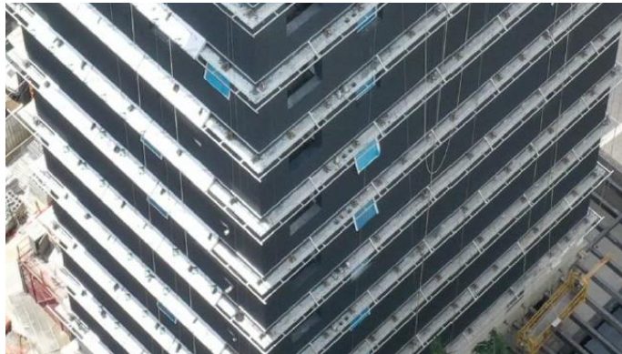
Figura 34- Montagem da Estrutura e conferência do nivelamento
