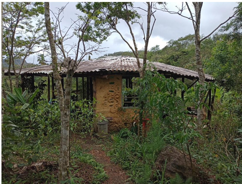
Fotografia 22: Parede de barro na “maloka”.
