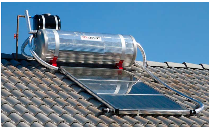
Figura 1: Sistema de energia solar térmico
