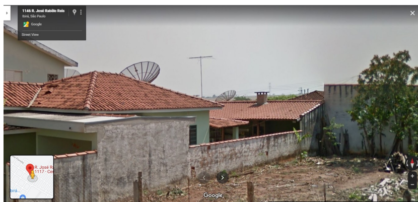
Figura 14: Vista parcial do telhado.
