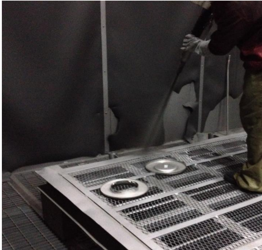
Figura 18: tampas dos filtros sendo jateadas
