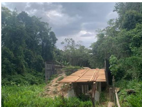
Figura 18 - Ponte nova com estrutura de concreto armado que foi iniciada e ainda não concluída.
