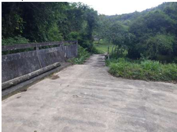
Figura 14 - Ponte do Maluf, que dá acesso ao bairro e a sede da associação Rib. dos Camargo, terminada somente até a metade do rio, com a outra parte feita de madeira.
