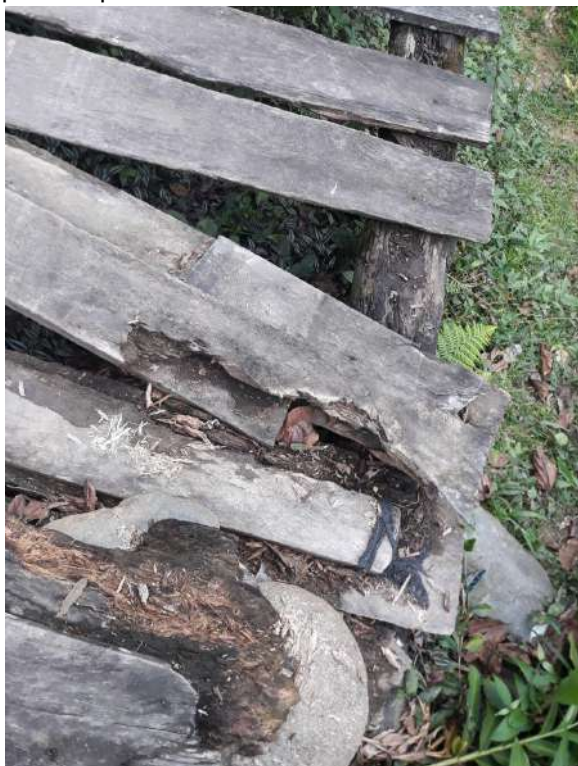
Figura 16 - Parte improvisada da ponte do Maluf, para acesso de pedestres ao bairro. Com detalhe para o apodrecimento das tábuas.
