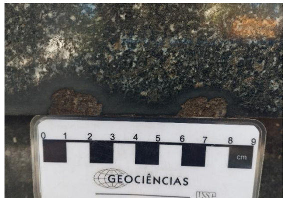
Figura 29: Dano de impacto no túmulo de Granito Preto Bragança.
