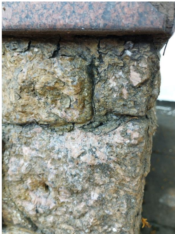
Figura 55: Descamação da tinta utilizada em túmulo de Granito Vermelho Bragança.
