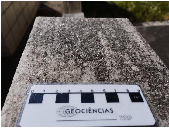
Figura 25: Sugaring em túmulo de mármore.
