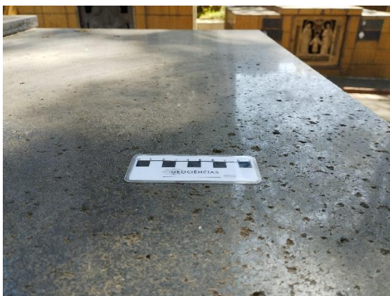
Figura 33: Descamação em túmulo de Granito Café Imperial.
