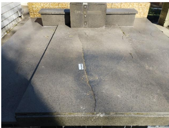
Figura 19: Fratura no tampo do túmulo, há também perfurações, objetos faltantes e depósito de massa.
