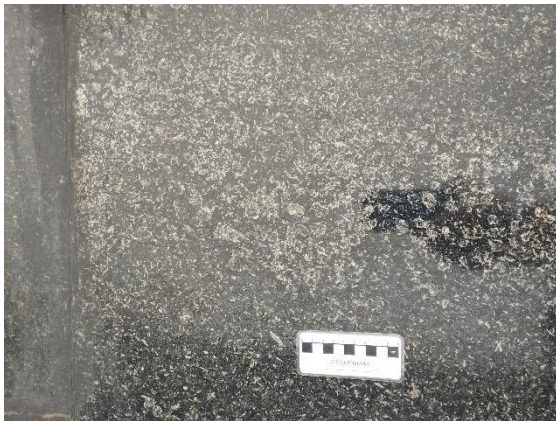
Figura 26: Destacamento pelicular em túmulo de Granito Preto Piracaia.
