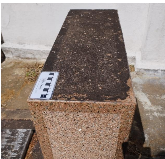
Figura 38: Filme negro em túmulo de Granito Rosa Itupeva.
