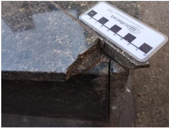
Figura 31: Lacuna em túmulo de Granito Verde Ubatuba.
