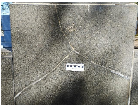
Figura 20: Fenda em estrela em túmulo de Granito Café Imperial.
