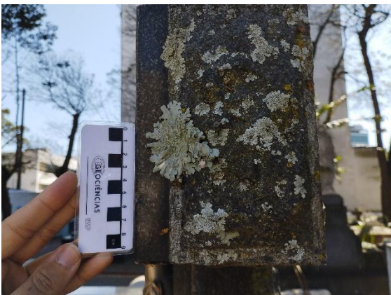
Figura 39: Colonização biológica por musgo e líquen em túmulo de Granito Preto Bragança.
