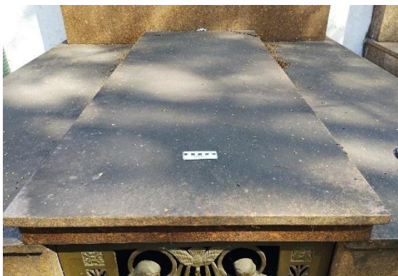
Figura 37: Sujidade em túmulo de Granito Vermelho Bragança.
