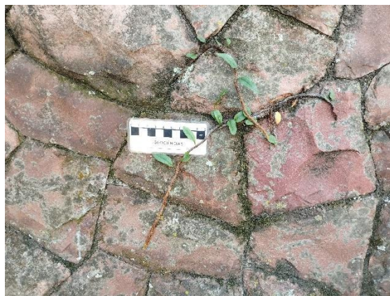
Figura 40: Colonização biológica por plantas, musgos e algas em túmulo de Arenito Vermelho Botucatu.
