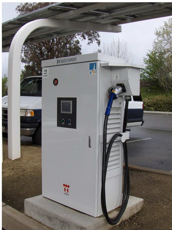
Figura 33 – Conversor AC-DC para carregamento direto de baterias
