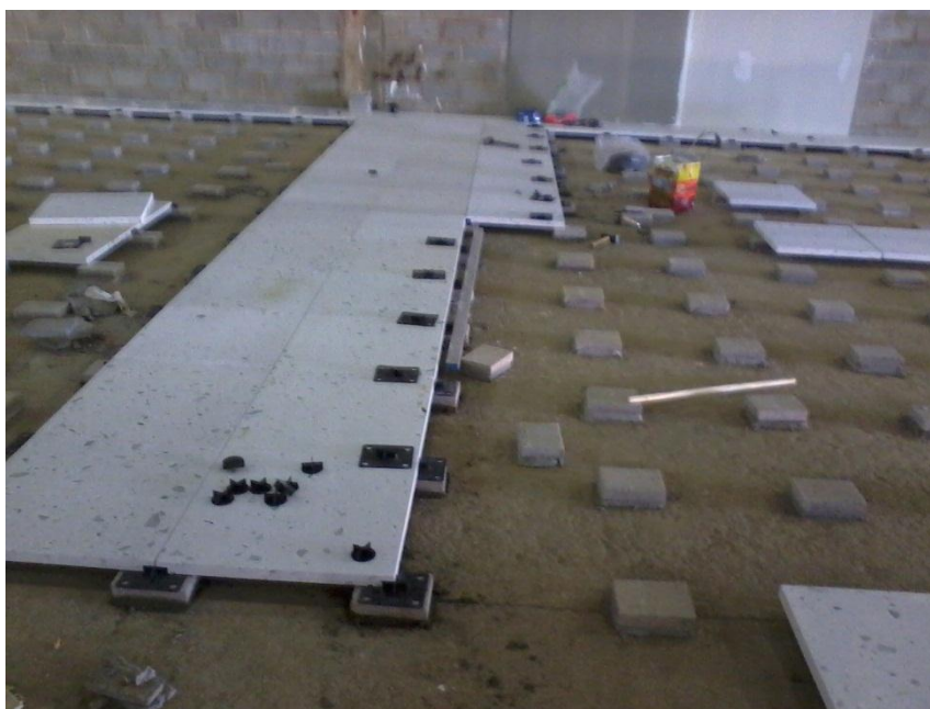
Figura 22. Instalação de revestimento pétreo. Fonte: acervo LAR Construtora.
