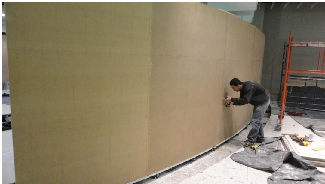
Figura 30. Fixação das divisórias dos provadores. Fonte: acervo LAR Construtora.
