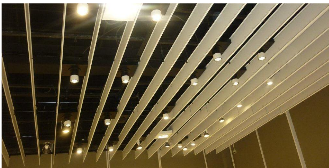
Figura 26. Detalhe da não linearidade e não continuidade do forro. Fonte: acervo LAR Construtora.
