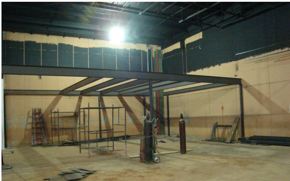
Figura 17. Execução de estrutura metálica. Fonte: acervo LAR Construtora.
