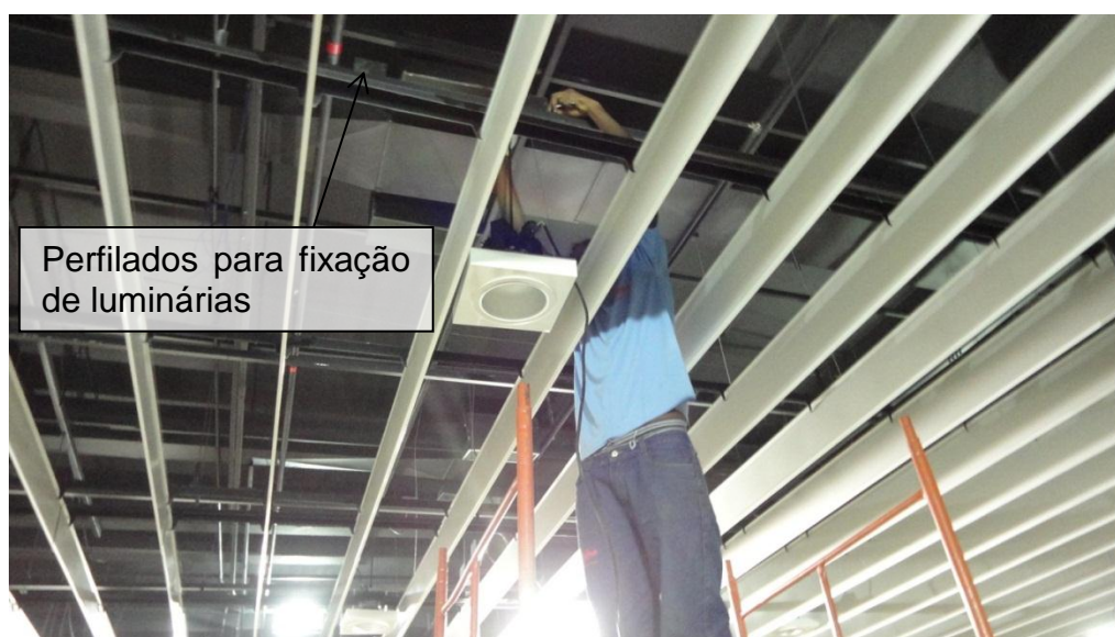
Figura 29. Instalação de perfilados para luminárias. Fonte: acervo LAR Construtora.
