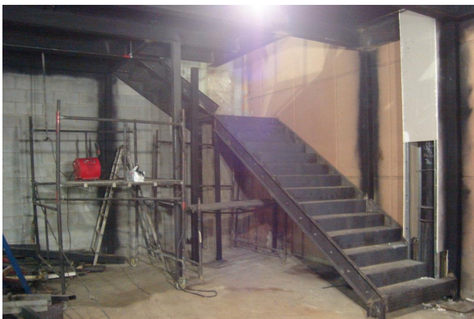
Figura 18. Execução de escada metálica. Fonte: acervo LAR Construtora.
