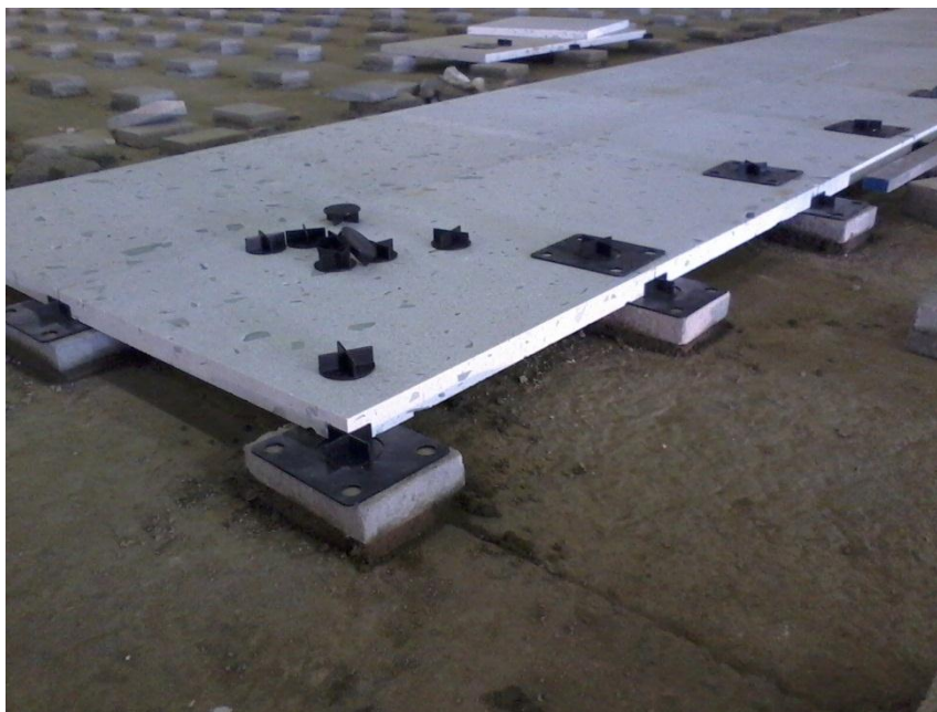
Figura 21. Detalhe do apoio metálico. Fonte: acervo LAR Construtora.
