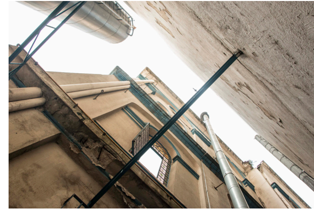
Vista do espaço entre o Classes Laboriosas e o edifício vizinho; escada interna em 2016.
