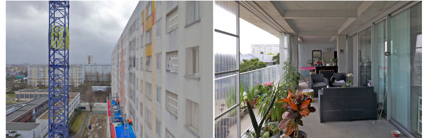
figura 08 · Antes e depois da transformação de 530 unidades habitacionais, edifícios G, H, I, quartier du Grand Parc - Lacaton e Vassal, Druot, Hutin. (Foto: Philipe Ruault)
