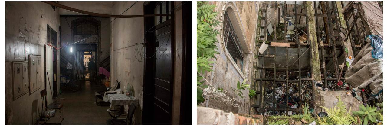
Entrada do edifício; vista de onde estava localizado o palco.
