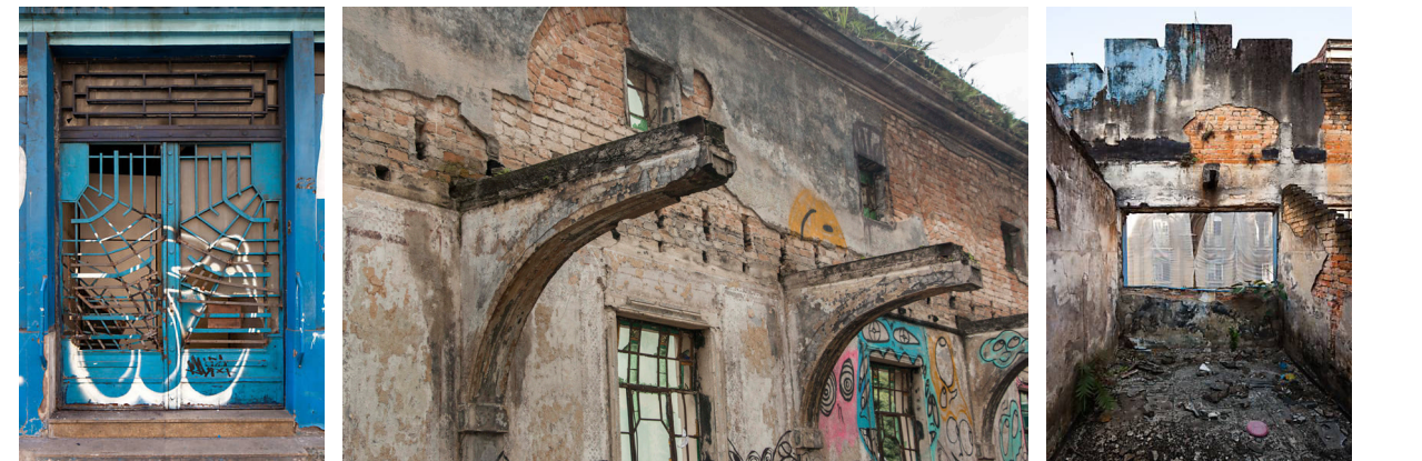
Entrada principal do edifício; consoles que serviam de apoio às frisas; vista por detrás da fachada. Fotos: Gabriel Pietraroia e Ryan Wolf.
