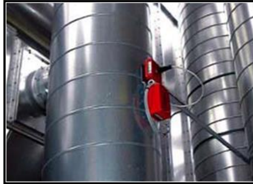
Figura 33 – Detector instalado no duto. Fonte: Parte do catálogo – www.grecon.com
