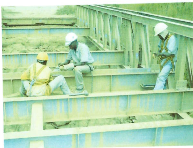
Figura Nº 11 – desmontagem da ponte.
