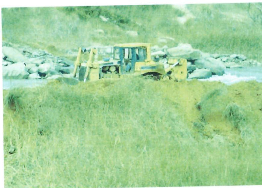
Figura 9 – Trator trabalhando no alargamento do dique.
