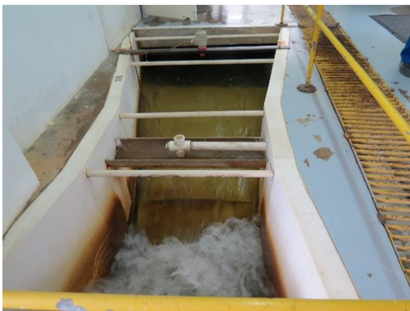
Figura 4.4 – Calha Parshall da unidade de mistura rápida
