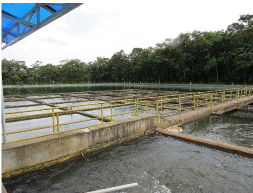
Figura 4.3 – Unidade de pré-tratamento
