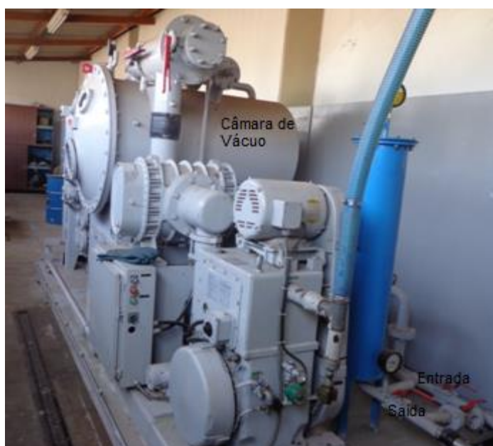
Figura 16: Sistema de aquecimento do óleo
