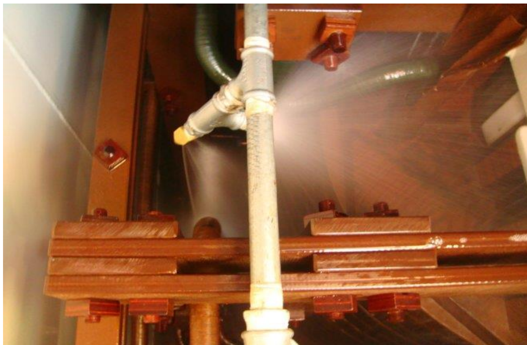
Figura 17: Bicos aspersores instalados dentro do transformador
