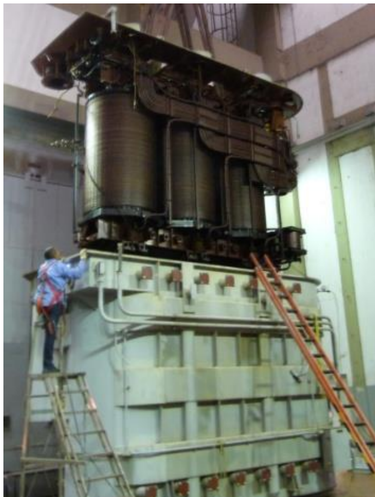
Figura 2: Transformador Trifásico de Transmissão
