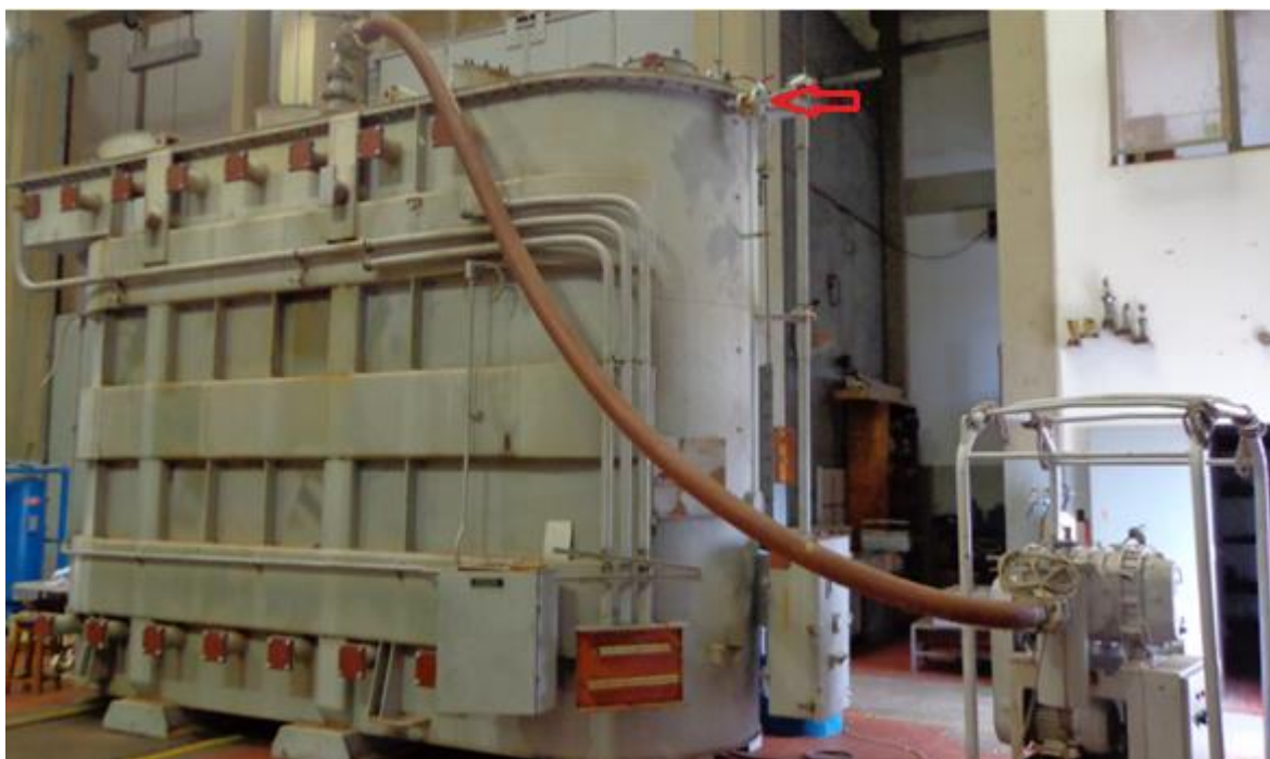
Figura 13: Conexão da bomba de vácuo
