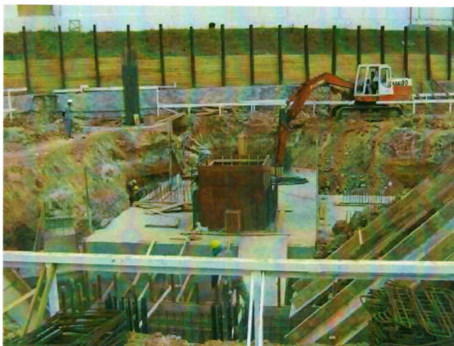
Figura 24 – Sapata de fundação
