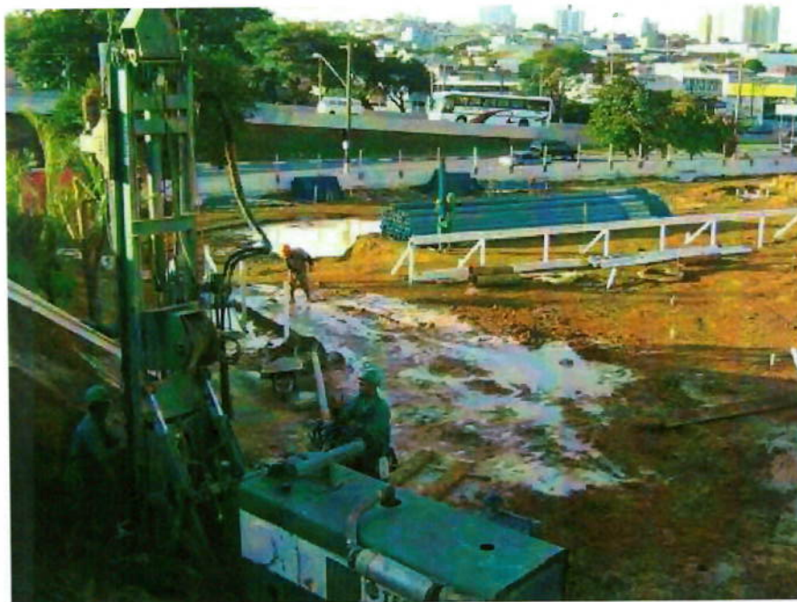
Figura 20 – Equipamento de perfuração do terreno para instalação de tubos de dreno para rebaixamento do lençol freático.
