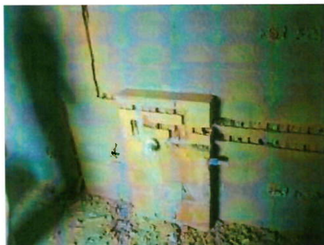
Figura 32 – Instalação hidráulica com corte na alvenaria para embutimento das instalações
