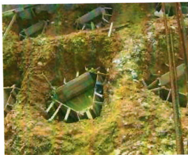
Figura 28 – Fôrma dos blocos com madeira serrada.
