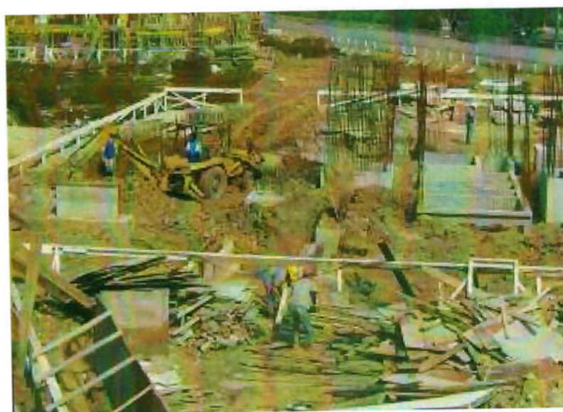
Figura 29 – Detalhe da execução dos baldrames
