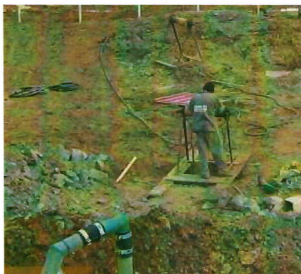
Figura 22 – Operação de retirada de terra da escavação de tubulação realizada manualmente.
