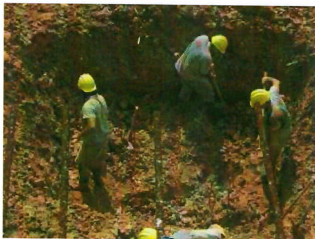
Figura 25 – Detalhe da escavação manual de baldrame.
