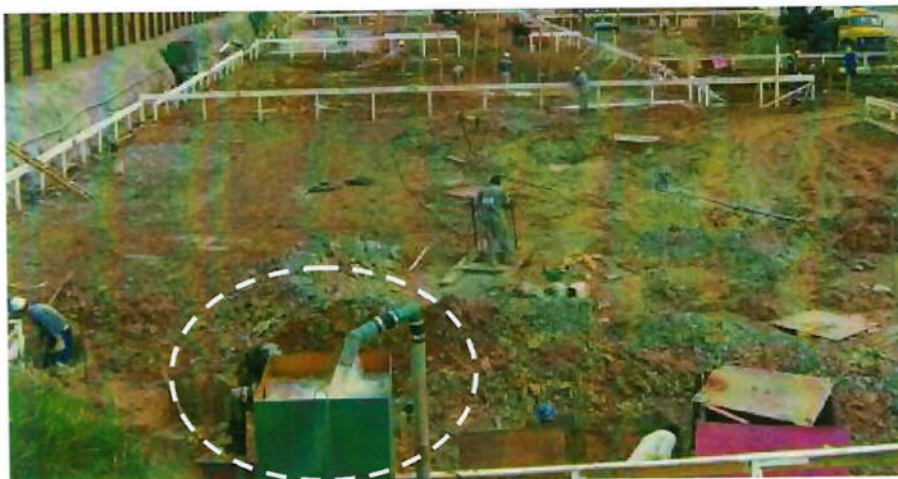
Figura 21 – Terreno após o rebaixamento do lençol freático e detalhe do equipamento de bombeamento de água.
