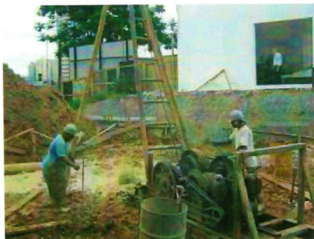
Figura 18 – Execução de estaca Strauss próximo ao estande de vendas.
