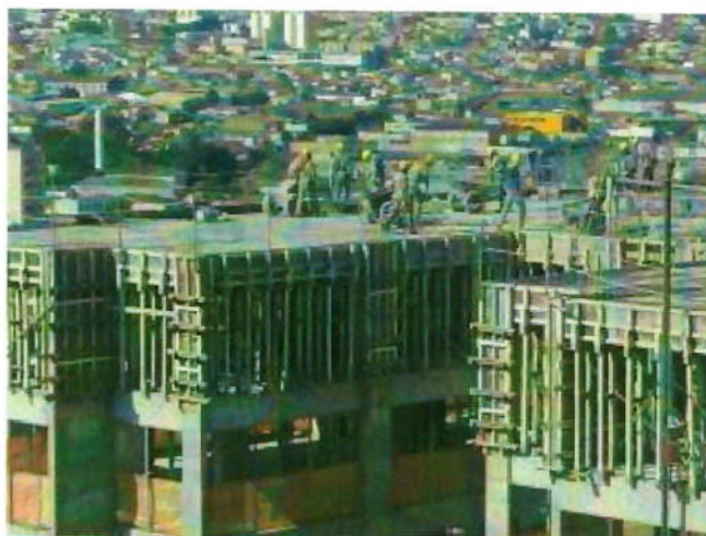
Figura 36 – Sistema de fôrma com uso madeira.
