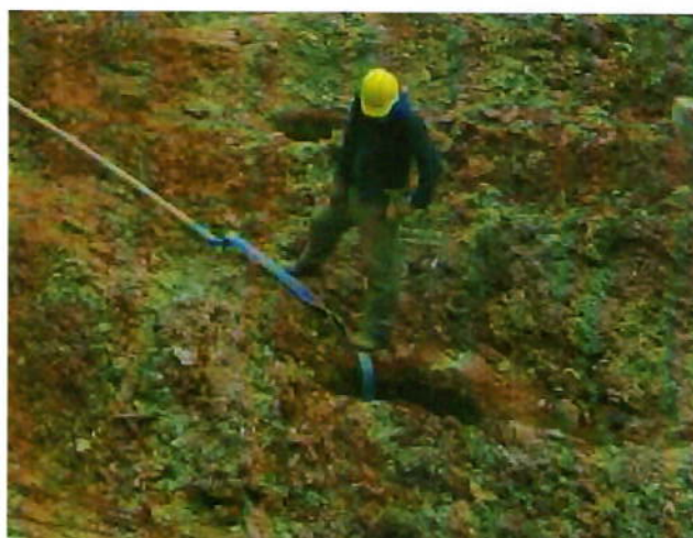
Figura 23 – Bombeamento de água de dentro do furo do tubulão.
