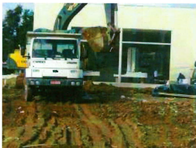
Figura 17 – Serviço de escavação com interferência do estande de vendas.
