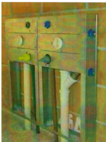
Figura 33 – Instalação hidráulica com sistema racionalizado de kits e fechamento de gesso acartonado.
