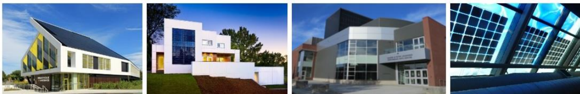
Figura 20 - Exemplos de instalações BIPV no Canadá (de esquerda para direita: Maxime Gagné, One House Green , Universidade de Alberta e Véronique Delisle). Fonte: Governo do Canadá, 2018.
