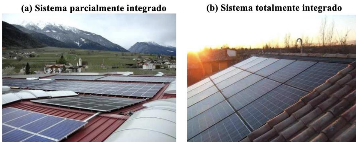
Figura 15 - Exemplos de sistemas solares parcialmente e totalmente integrados à edificação. Fonte: IEA, 2019.
