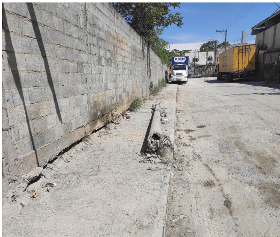
Figura 2 – Poste de energia elétrica destruído na Rua Eugênia.
