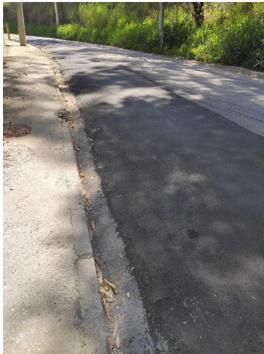
Figura 7 – Asfalto com remendos na Av. Jordano Mendes.
