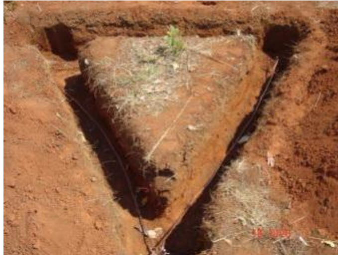
Figura 16 - Aterramento real em triângulo equilátero
