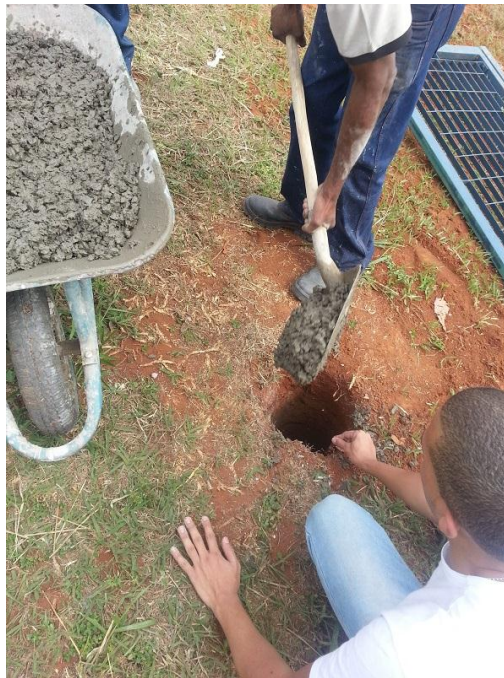
Figura 44 – Preenchimento do furo
