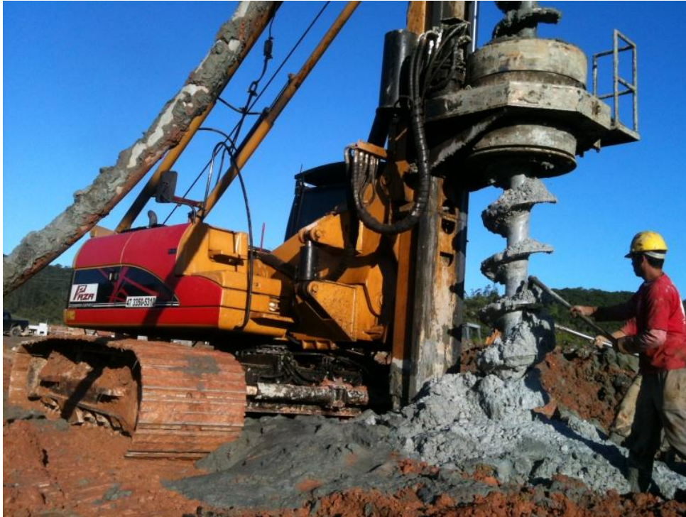
Figura 39 - Máquina perfuratriz utilizada para grandes furos
