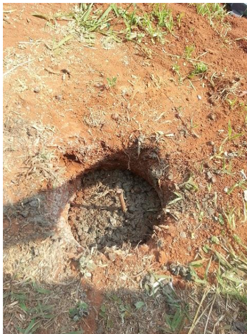
Figura 45 - Furo preenchido e haste inserida
