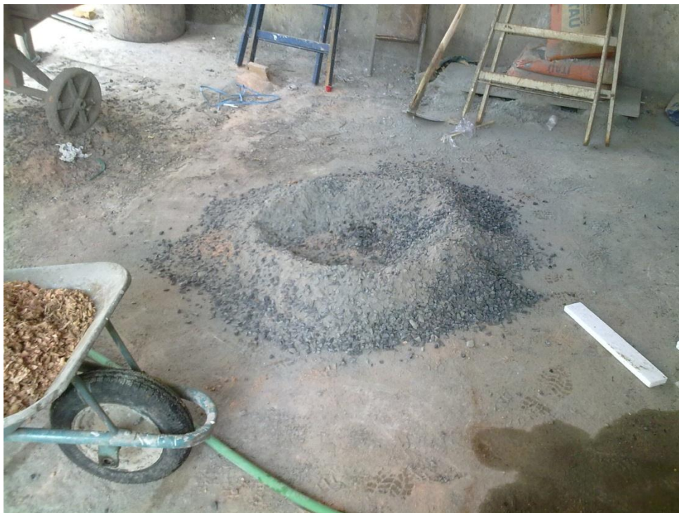
Figura 41 - Cimento e pedra sendo preparados
