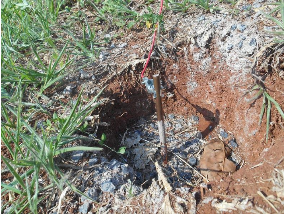
Figura 49 - Haste cravada no concreto e conectada ao fio do Megger
