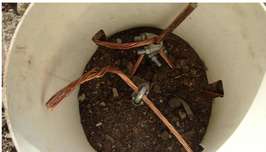
Figura 1 - Haste cobreada enterrada no solo e conectada ao fio terra
