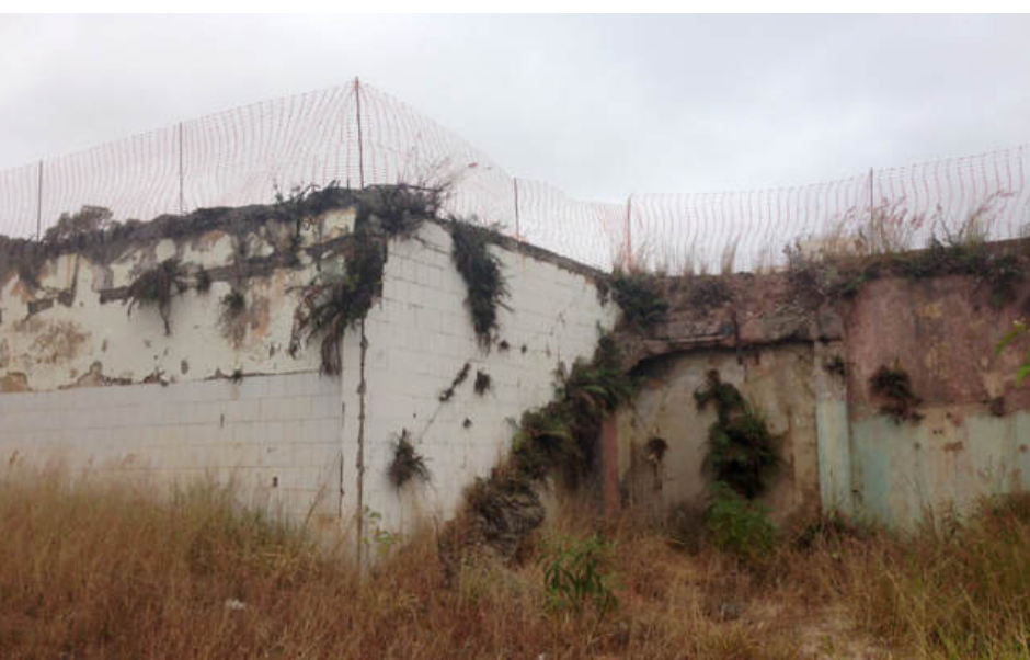
muro de arrimo com revestimento remanescente
