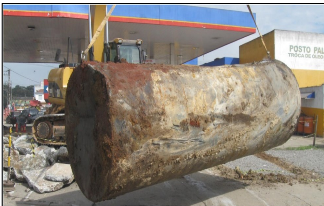
Figura 2- Tanque subterrâneo em aço Removido.
