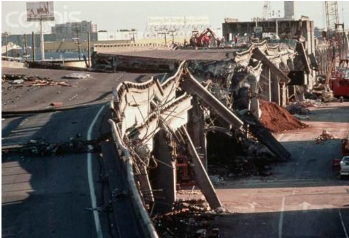
Figura 36- Pier Freeway após o terremoto Loma Pietra. Fonte: http://prologispier1.com/ Acessado em 12/10/2015
