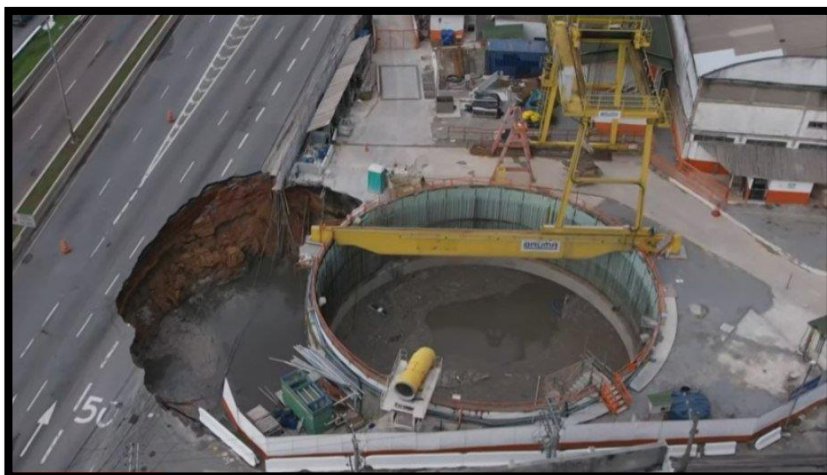
Figura 15: Cratera aberta na Marginal Tietê em 01 de fevereiro de 2022, através do rompimento pelo “tatução” de um cano do esgoto da Sabesp, ocasionando na abertura do buraco 79 .
