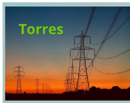
Figura 6 - Torres de linhas de transmissão
