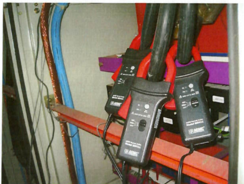
Figura 10.0 Garras de corrente ligadas as 3 fases.
