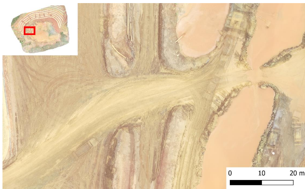
Figura 36 – Detalhe do ortomosaico, maquinário pesado abrindo acessos, removendo material do reservatório e rastros de seus movimentos, 22 de outubro.
