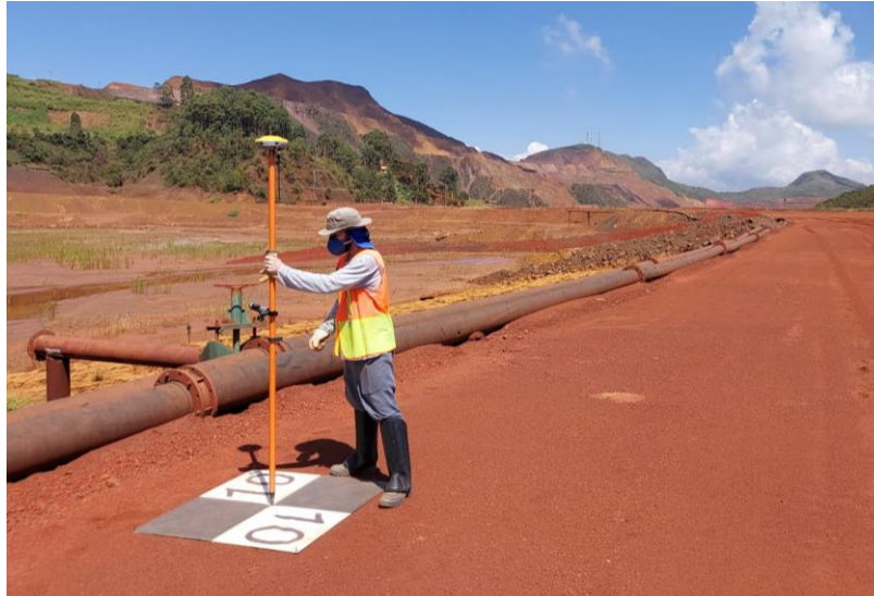
Figura 8 – Coletando as coordenadas dos pontos de controle na barragem de rejeitos utilizando RTK, alvo preto e branco com medidas de 1x1 metro.
