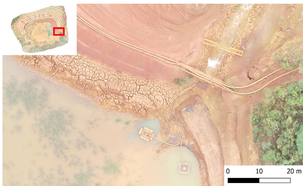
Figura 37 – Bombas extraíndo a água e a formação de gretas de contração a montante devido o rebaixamento do reservatório e sinais de erosão próximo a tubulação, 22 de outubro.
