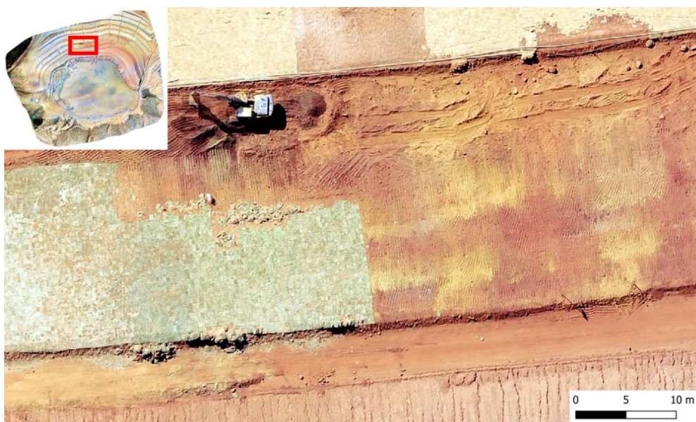
Figura 33 – Detalhe do ortomosaico a jusante, maquinário espalhando terra para o nivelamento do talude, 13 de agosto.
