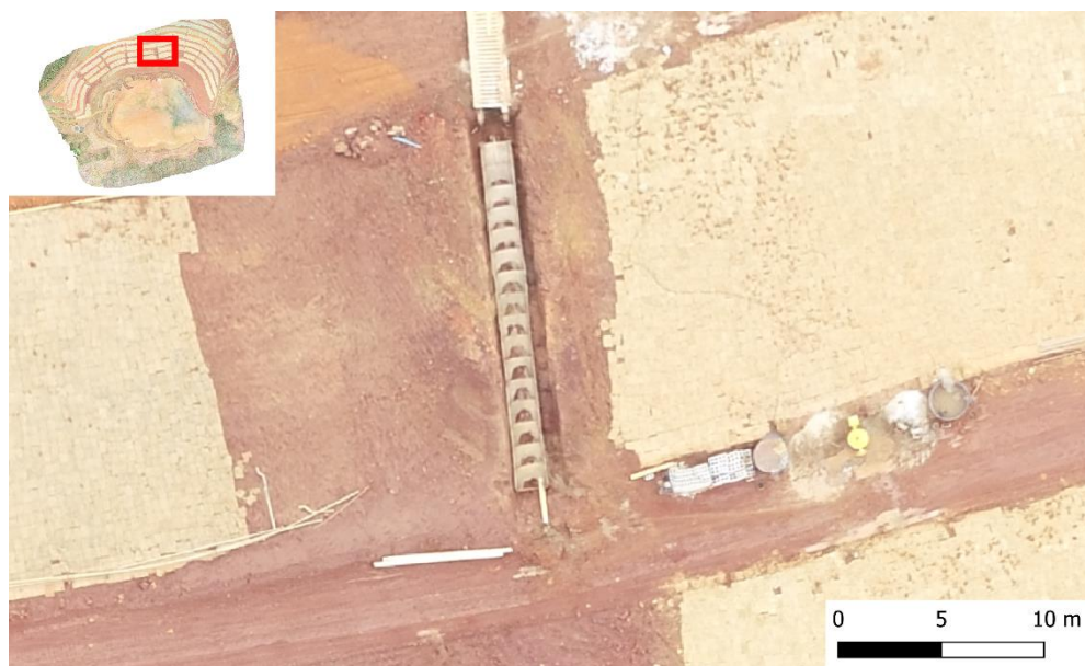
Figura 38 – Detalhe do ortomosaico a jusante, construção de escada hidráulica no talude, 22 de outubro.
