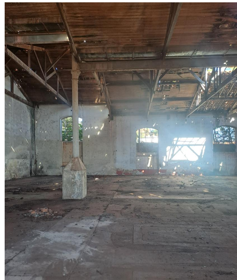
Forro em madeira presente no terceiro pavimento e Pilar com reforço estrutural que mostra a mudança de nível de piso realizada no local. Fonte: Autora, 2024.
