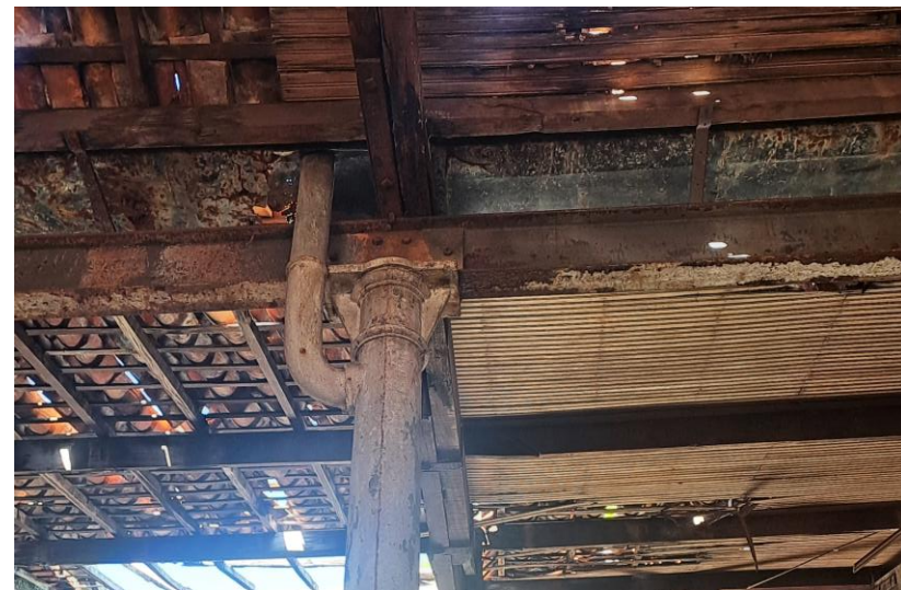
Tubo condutor de água, da calha para o interior do pilar. Fonte: Autora, 2024.
