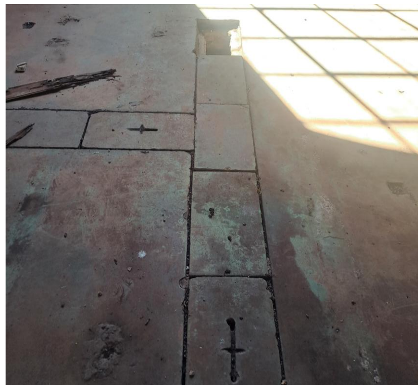
Detalhe do piso removível para a manutenção das canaletas de transporte de água. Fonte: Autora,, 2024.
