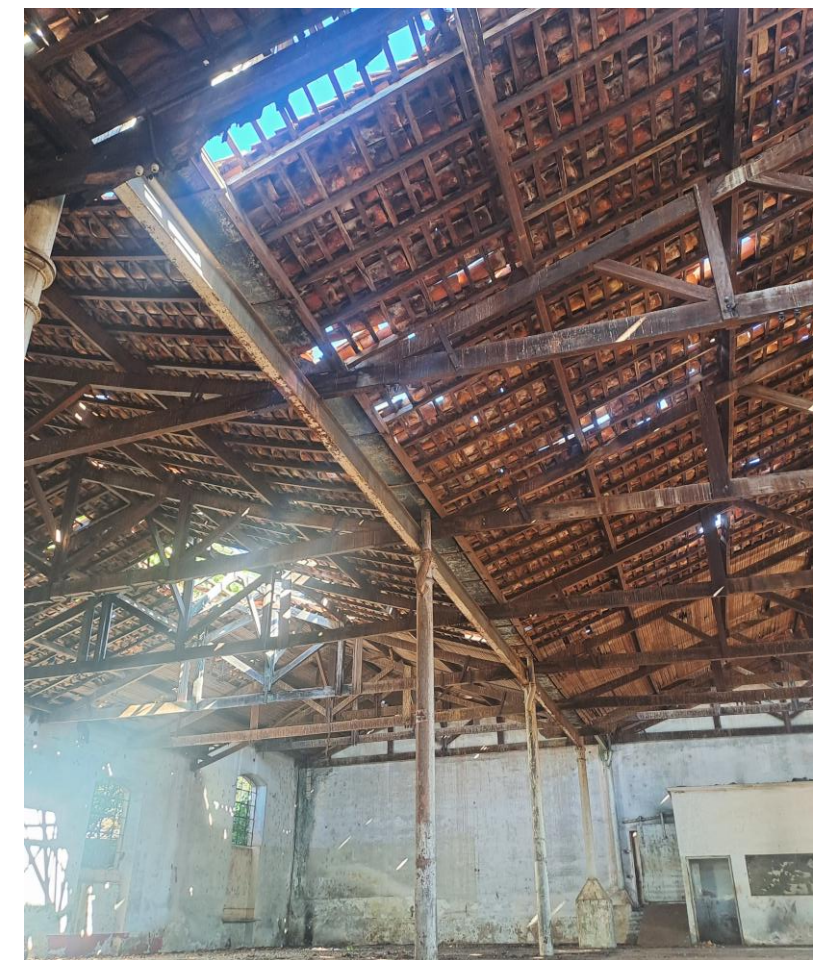
Cobertura sustentada por sistema estrutural composto por treliças em madeira. Fonte: Autora, 2024
