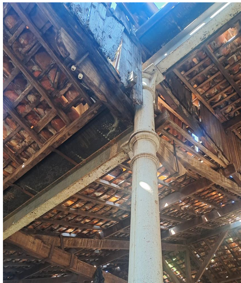
Encontro do pilar com as vigas que sustentam a cobertura do edifício. Fonte: autora, 2024.
