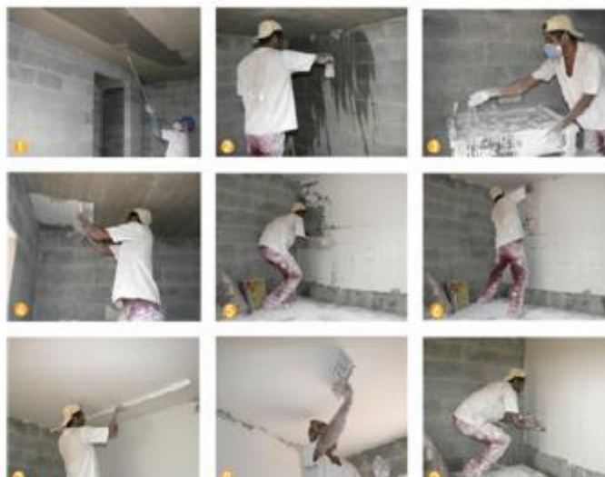
Figura 94: Execução do gesso desempenado
