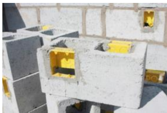
Figura 91: Caixas elétricas fixadas aos blocos
