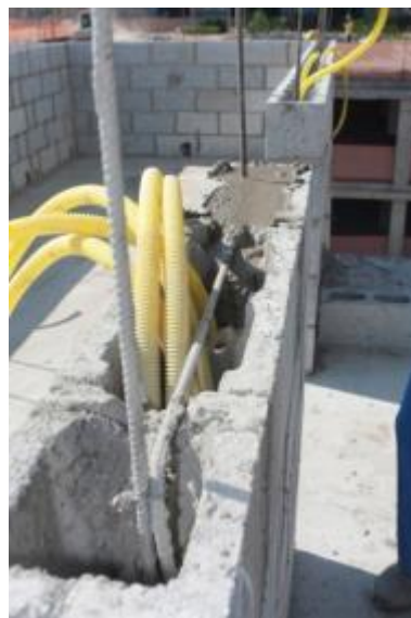
Figura 90: Passagem de eletrodutos pelos blocos
