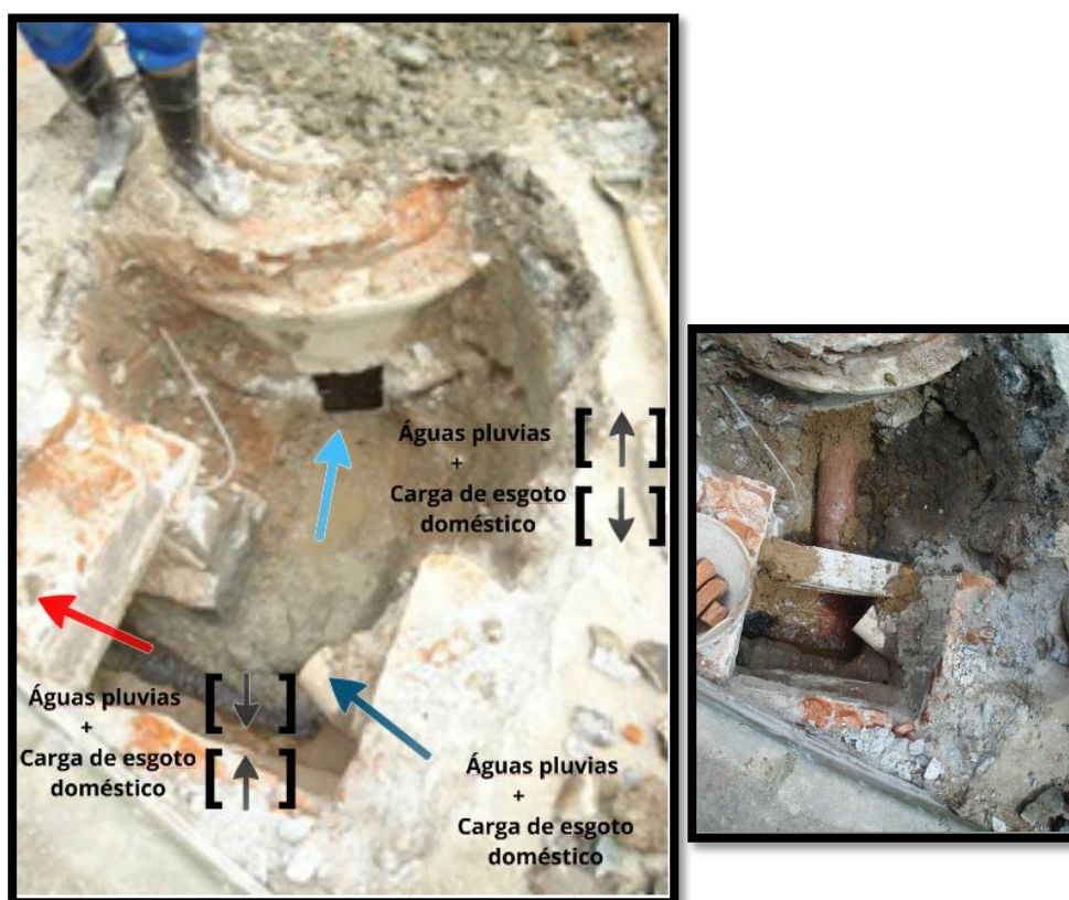
Figura 11. Sistema de captação de esgoto em tempo seco na microbacia do córrego Pedra Branca.
