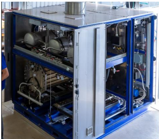
Figura 12 - Eletrolisador do Parque Tecnológico de Itaipu
