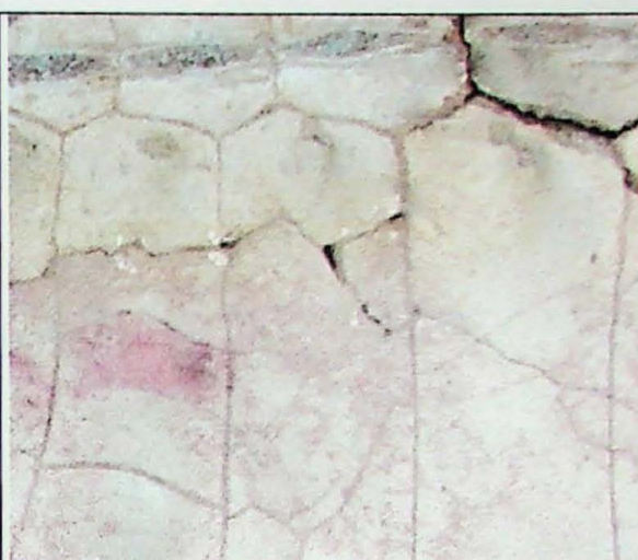
Foto 2: Presença de quebra diferenciada na região interior das placas. Largura da base: 5cm.
