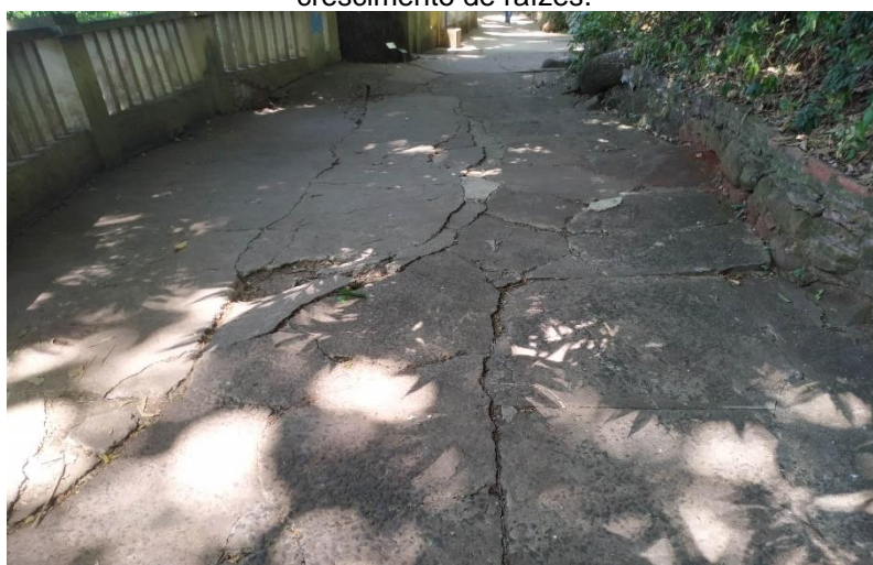
Figura 15 Foto de uma parte do trajeto do Parque do Mirante, mostrando o pavimento danificado pelo crescimento de raízes.
