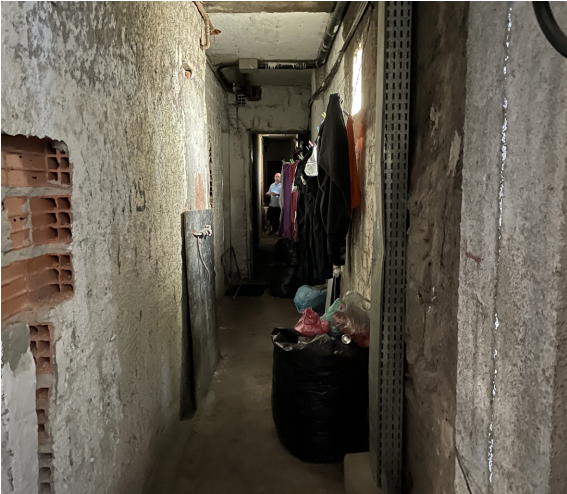
Imagens 10 e 11: Eletrocalha que atravessa o térreo e segue verticalmente pelos pavimentos superiores | Fonte: Acervo pessoal | 2022
