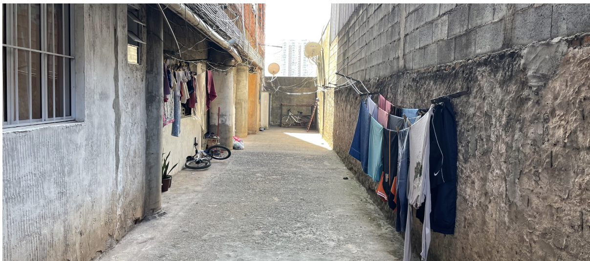
Imagens 15 e 16: Subsolo e corredor do térreo | Fonte: Acervo pessoal | 2022
