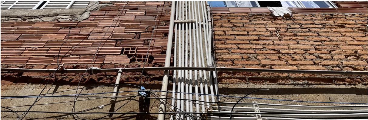
Imagem 14: Instalações aparentes na fachada | Fonte: Acervo pessoal | 2022
