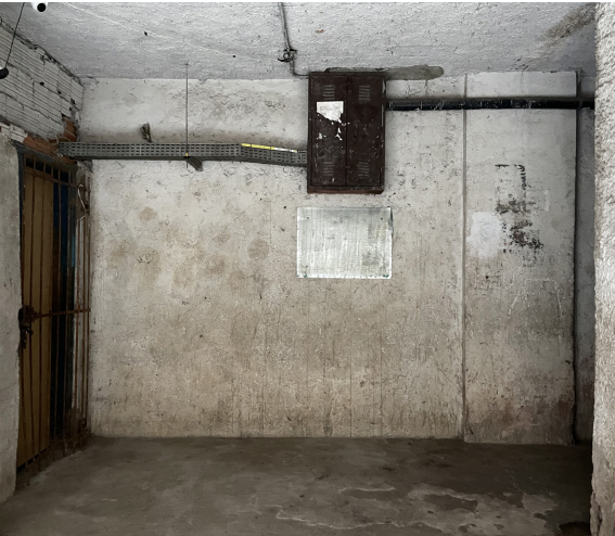
Imagens 10 e 11: Eletrocalha que atravessa o térreo e segue verticalmente pelos pavimentos superiores | Fonte: Acervo pessoal | 2022
