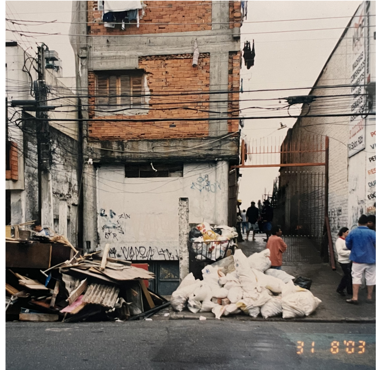
Imagem 07: Fachada do Edifício União antes da requalificação | Fonte: Acervo da Prof. Maria Ruth | 2003
