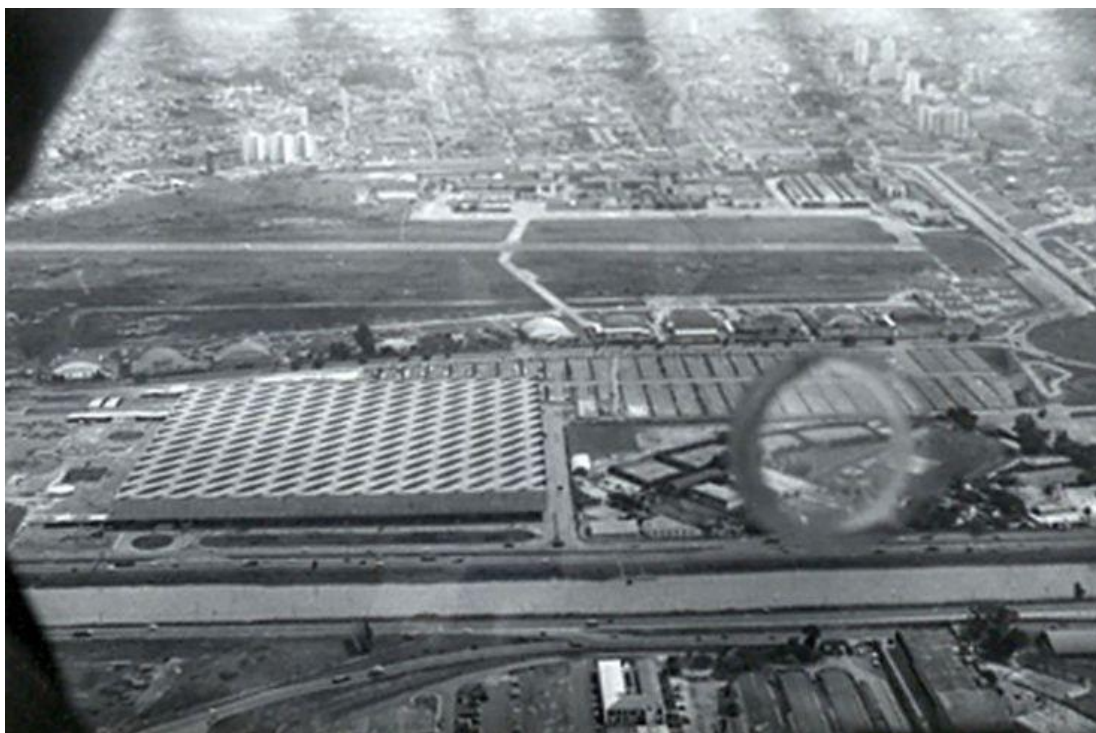
Figura 5 – Construção da cobertura do Pavilhão do Anhembi. Estrutura metálica em montagem horizontal.
