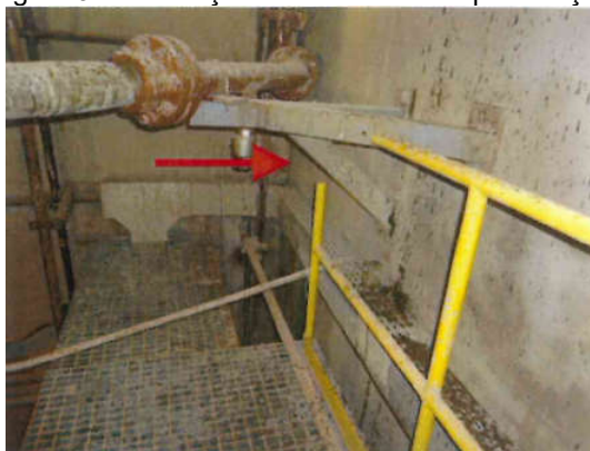
Figura 9 – Tubulação atravessando os passadiços
