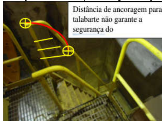
Figura 20 – Colocação de travessas para assegurar fixação de talabartes
