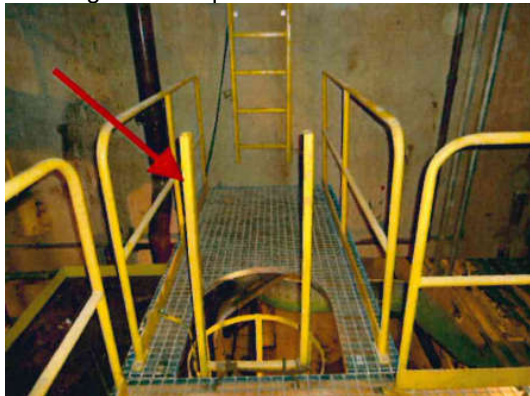
Figura 16 – Montagem inadequada de conexão de escada marinheiro
