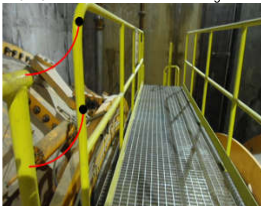
Figura 18 – Correntes unindo os trechos de guarda-corpos
