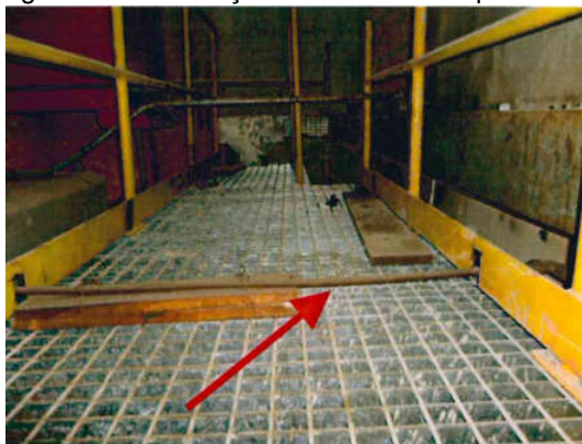
Figura 12 – Tubulação atravessando a passarela
