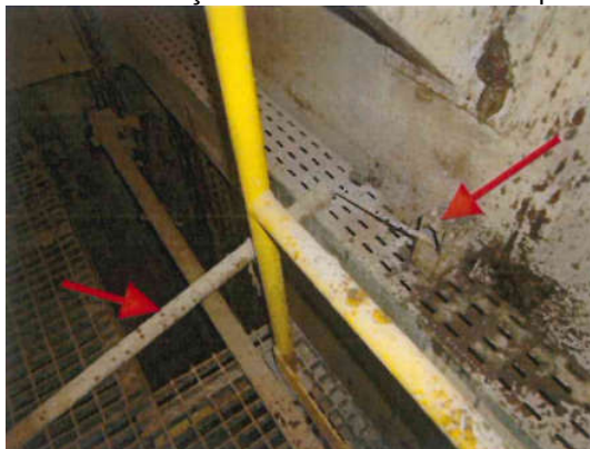
Figura 11 – Instalação elétrica atravessando o passeio.
