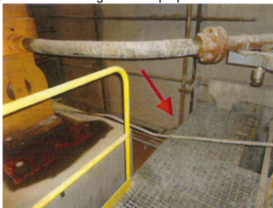
Figura 10 – Trechos sem guarda-corpo por interferência mecânica
