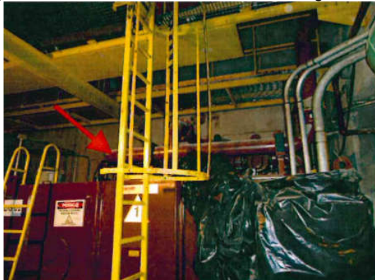
Figura 15 – Escada Marinheiro com montagem errada
