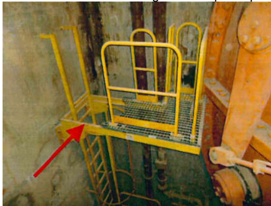
Figura 14 – Vãos abertos sem guarda-corpo ou proteção
