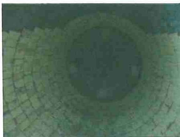
Figura 2.12. Assentamento do revestimento isolante de 16mm nas regiões do cilindro e cone
