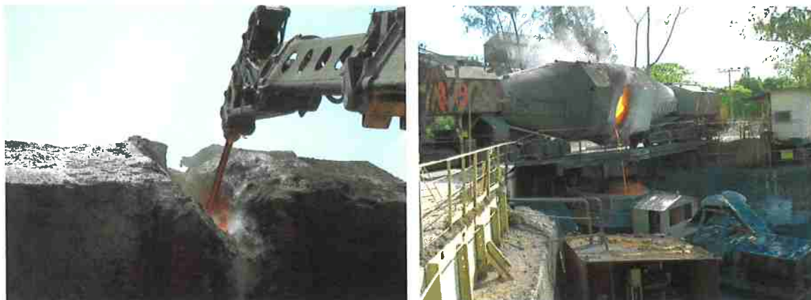
Figura 2.23. Eliminação de cascação na região da boca e zeragem do carro torpedo
