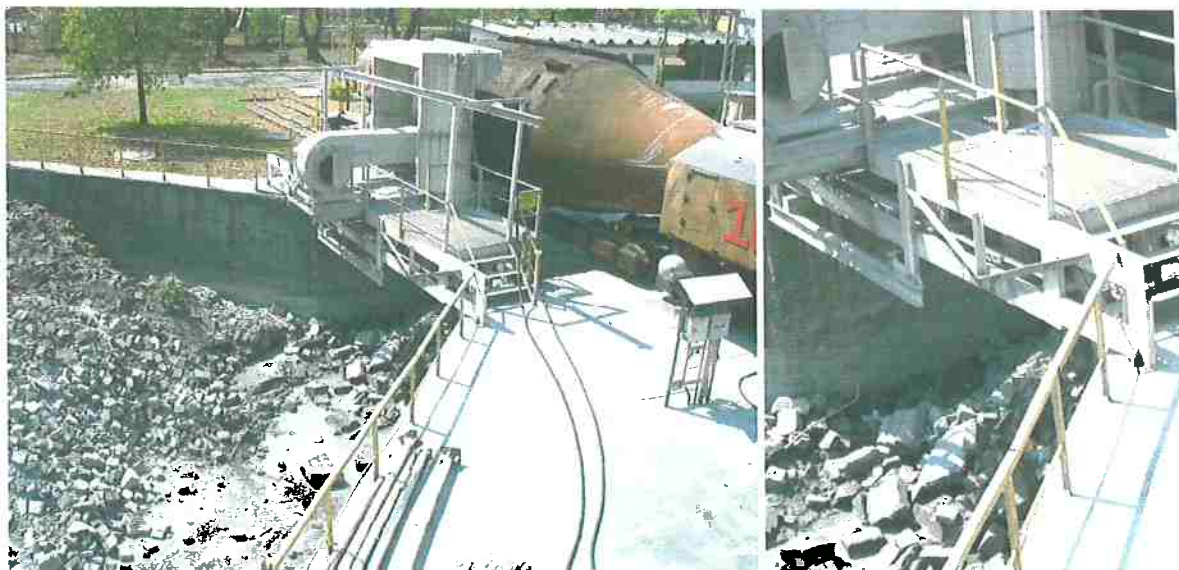
Figura 2.6. Fotos dos materiais refratários oriundos da demolição, após os giros de 360°
