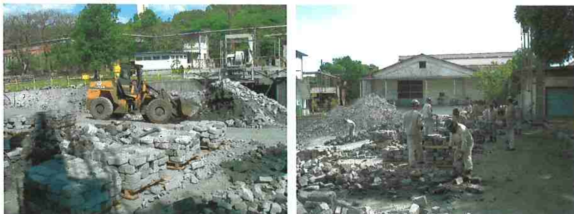
Figura 2.25. Espalhamento, separação, seleção e empadiolamento do material a ser reciclado.
