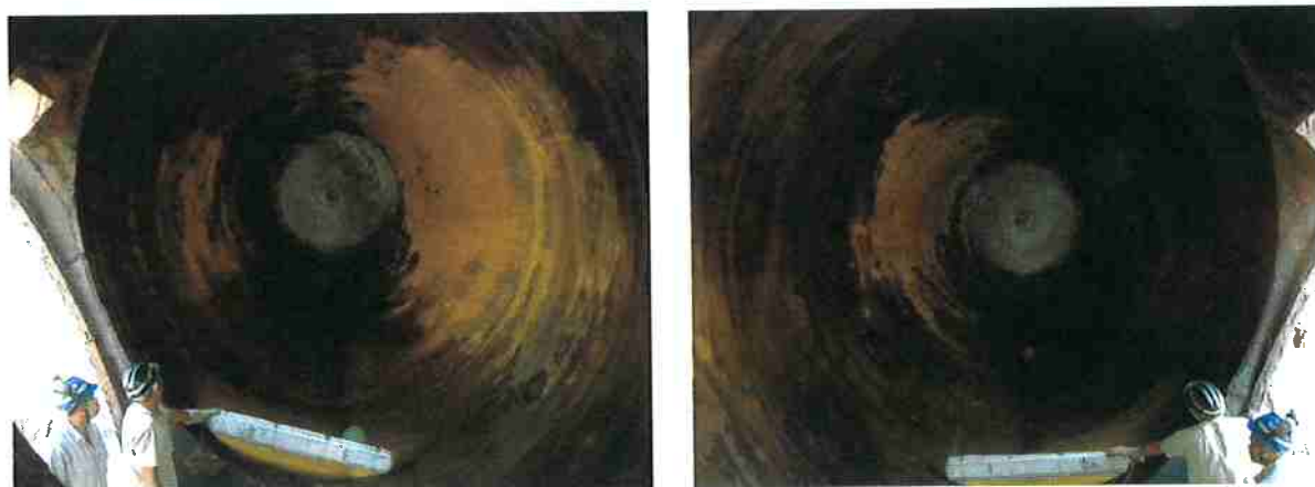
Figura 2.7. Fotos do interior do carro torpedo após demolição
