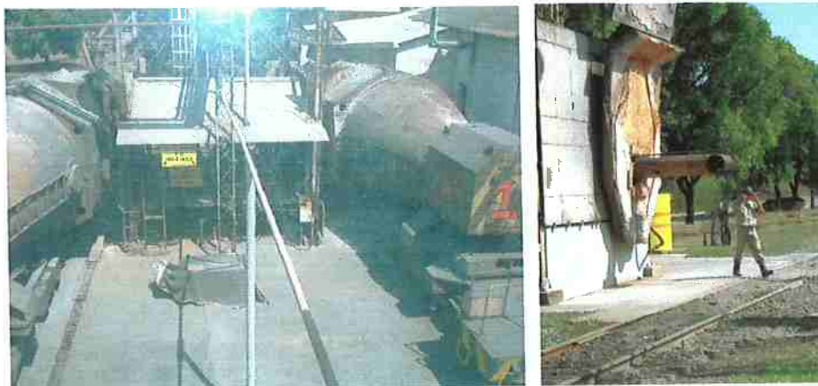
Figura 2.19. Estação de aquecimento e lança de aquecimento
