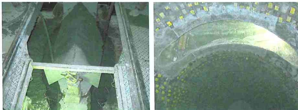
Figura 2.18. Aplicação do concretor refratário aluminoso de baixo cimento da região da boca
