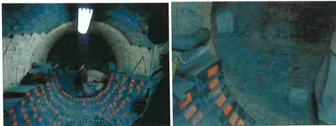
Figura 2.16. Assentamento do revestimento de alumina-carbeto de silício-carbono na parte inferior da região dos cones e calotas
