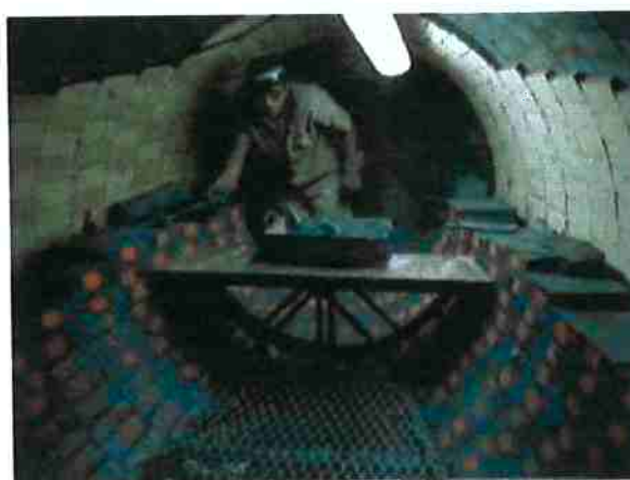
Figura 2.14. Assentamento do revestimento de alumina-carbetto de silício-carbono da região do cilindro
