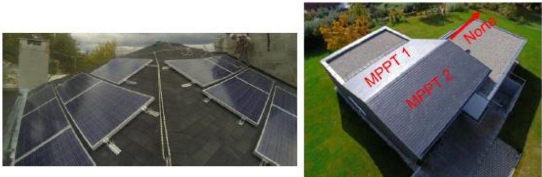
Figura 4.14 - Disposição dos módulos fotovoltaicos e respectivas MPPT's
